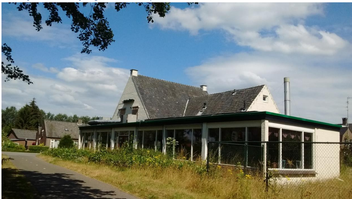
Oostelijke en zuidelijke gevel van het pand:
