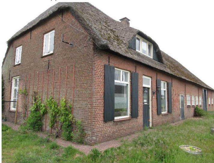
Voor- en linkerzijgevel
