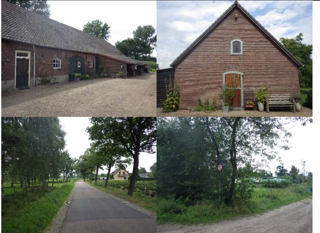
Figuur 2.2 Impressie van het plangebied met linksboven de te slopen boerderij, rechtsboven de te slopen paardenstal achter de boerderij, linksonder de Mezenlaan en rechtsonder De Hoefkens met daarachter de volkstuinjes
