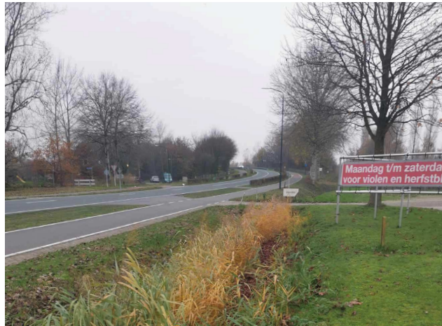
Figuur 11: Schijndelsedijk en viaduct over A2
