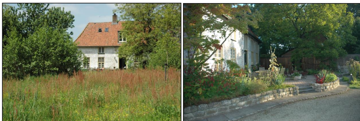
Figuur 16: Allure van het Herenhuis: de achterzijde van de zogenoemde 'Principale woning'
