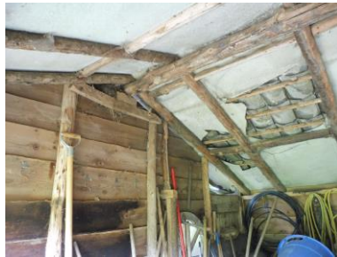
Te slopen paardenstalletje met gepotdekselde zijgevel en zicht op de binnenzijde dak.
