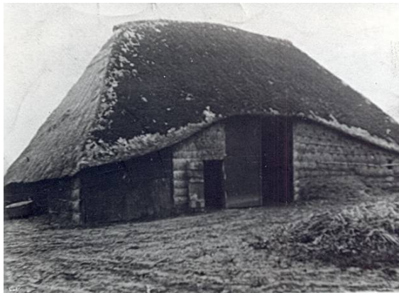
Dwarsdeelschuur met wanden van gevlochten stro. De deeldeuren bevinden zich in het midden van de lange gevel.
