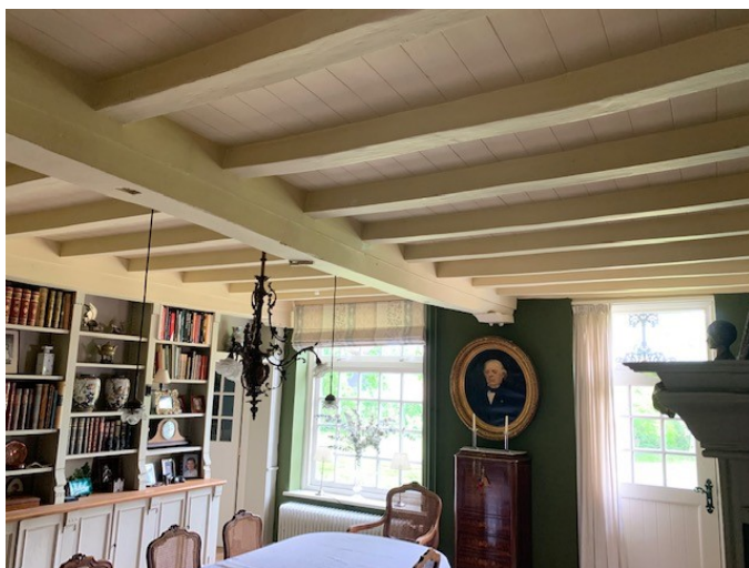
Samengesteld balkenplafond van De Ruiting 7 .met rechts: een van de twee sleutelstukken in de moerbalk.
