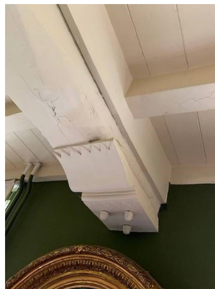
Samengesteld balkenplafond van De Ruiting 7 .met rechts: een van de twee sleutelstukken in de moerbalk.
