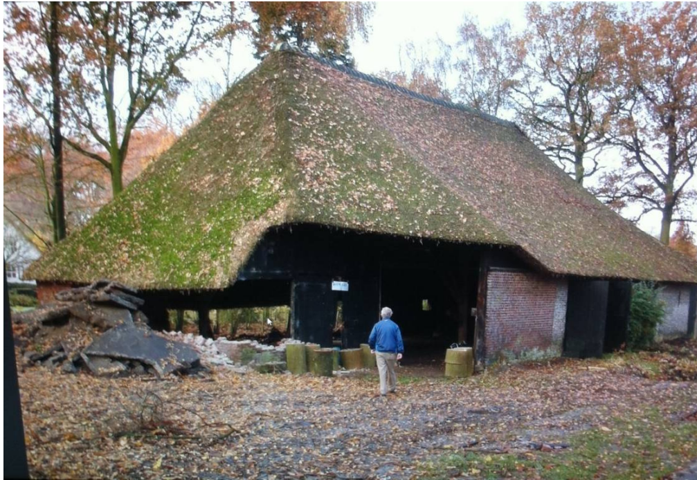
Schuur bij de demontage in Teteringen
