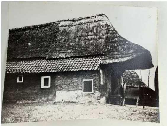
Achtergevel in de jaren zestig (fotocollectie Maurits en Martine van Bouwdijk)
