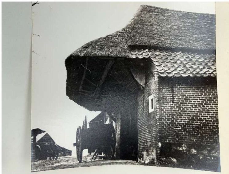
Eindgevel met de overstek uit de vroege jaren 1960. Onder de overstek staat de hoogkar. Midden in de gevel bevindt zich de dubbele mestdeur van de vroegere potstal. Het stukje voorgevel rechts is van ijsselsteen, gemetseld in kruisverband. (fotocollectie Maurits en Martine van Bouwdijk)
