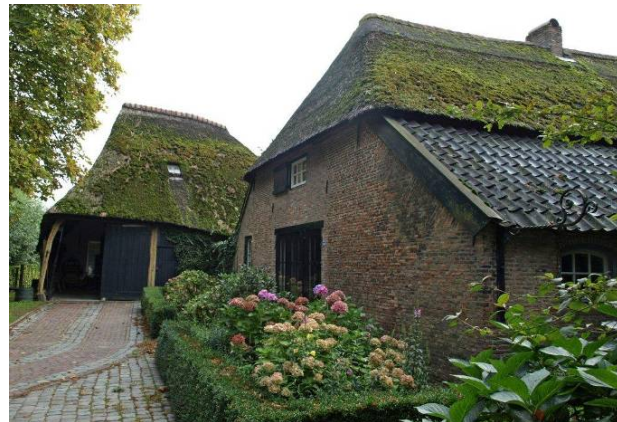
Zijdwarsdeelschuur met wanden van planken. De deeldeuren bevinden zich geheel links in de gevel.
