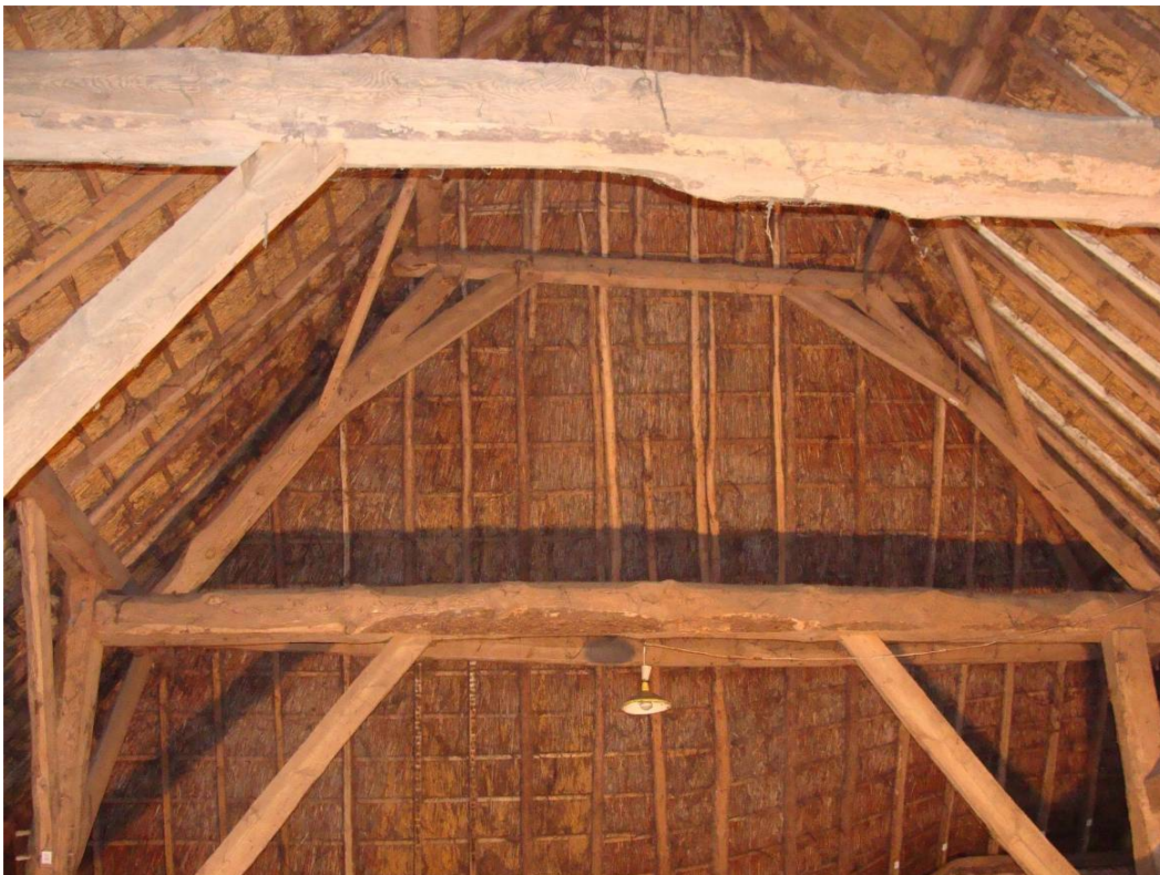
Eiken juk op de ligger van het eerste gebint. De kapconstructie heeft twee jukken en twee A-spanten.
