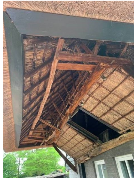
De overstek in gerestaureerde vorm
