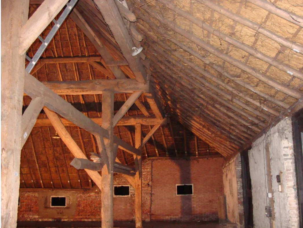
De deel van de schuur met achteraan de dichtgezette lage deeldeuren. Links tussen de stijlen de koppelbalken met schoren. Boven loopt de ligger op de stijl een stukje door.
