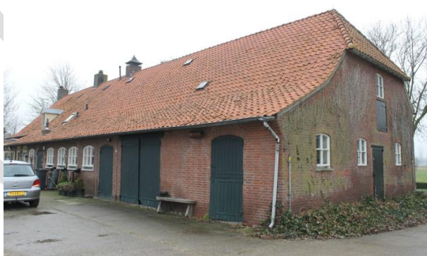
Oorspronkelijke achtergevel van het bedrijfsgebouwe
