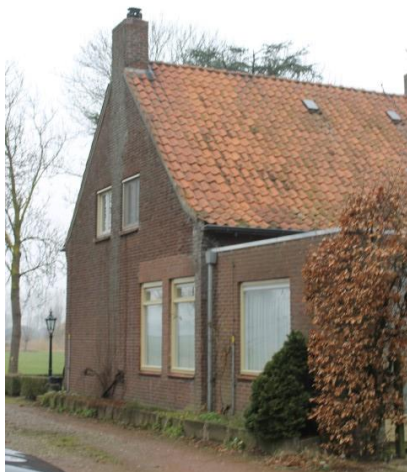
Rechterzijgevel met latere aanbouw
