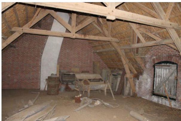
Onderste gedeelte A-spanten op zolder bedrijfsgedeelte
