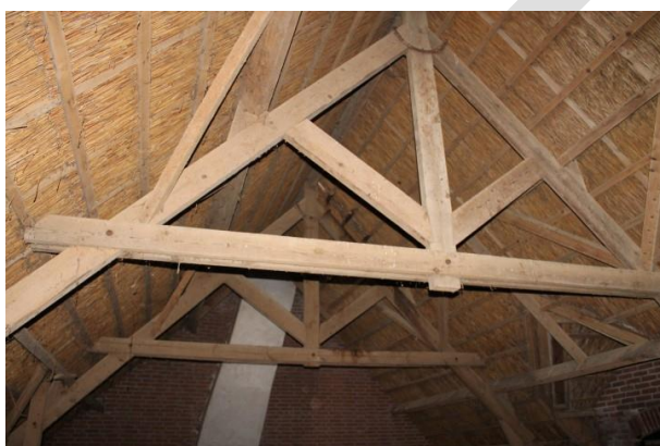
Bovenste gedeelte A-spant bedrijfsgedeelte
