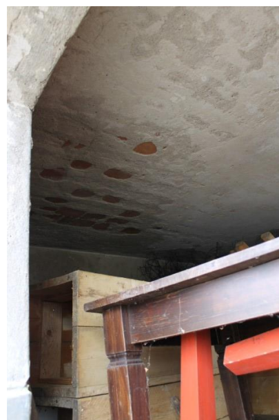
Onderzijde holle baksteen elementen paardenstal
