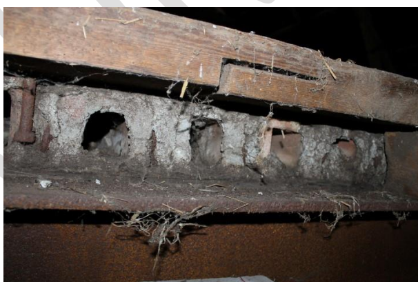
Holle bakstenen elementen van verdiepingsvloer
