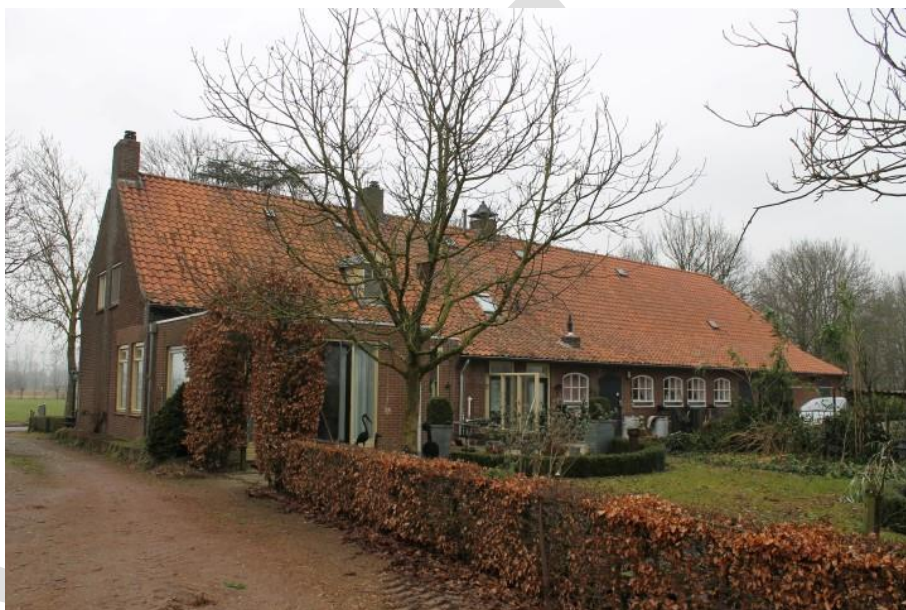
Achtergevel met links de latere aanbouw
