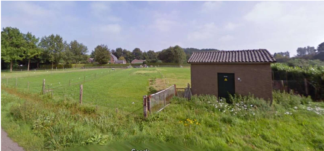
Figuur 3. Elektriciteitshuisje ten noorden van het plangebied
