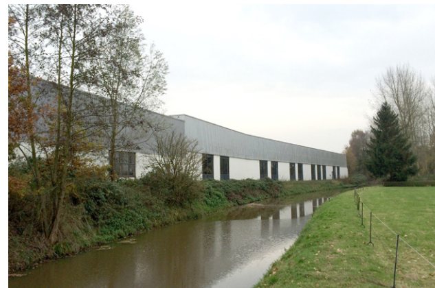
het Smalwater met bebouwing van bedrijventerrein Ladonk
