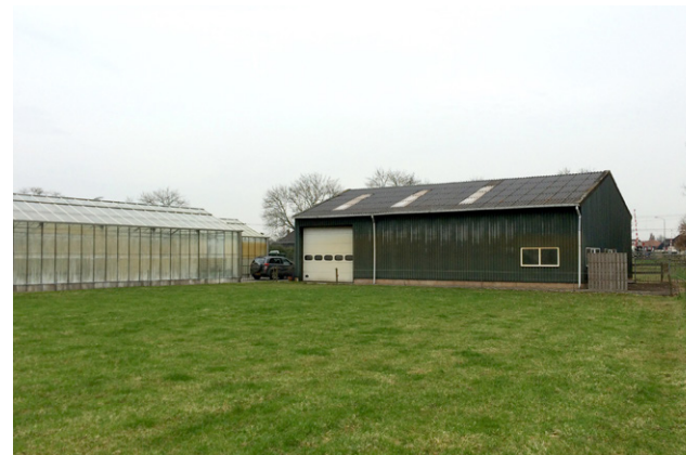
loods achterop het terrein
