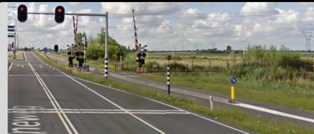
Vrijliggende fietspad met eigen middengeleider
