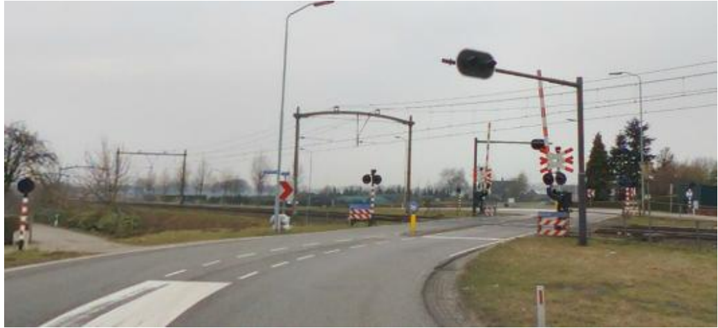
Figuur 3: Huidige overweg Kapelweg
