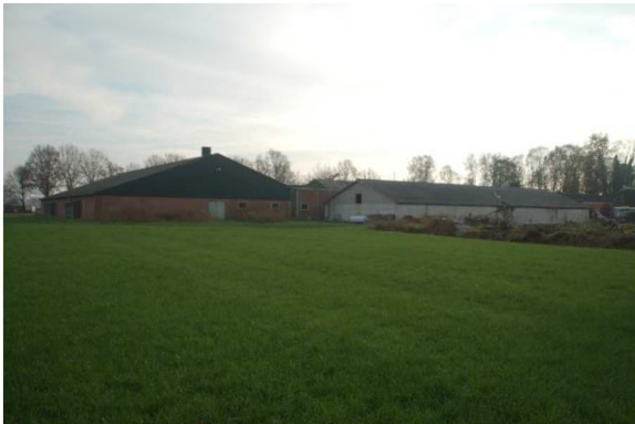
Achterzijde stal 4 met rechts gebouw 3
