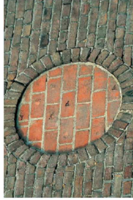
Figuur 20: dichtgemetselde toegang (bron: Vogebescherming Nederland)
