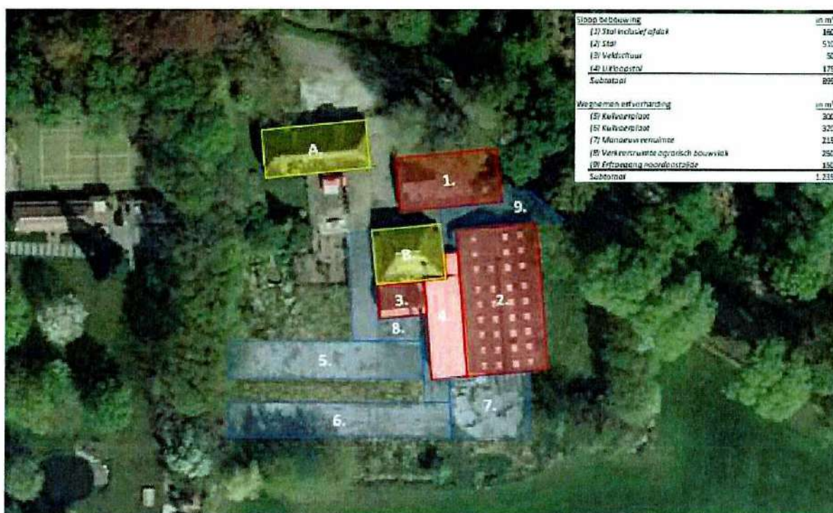
Luchtfoto met te behouden bebouwing met langgevelboerderij (A), de cultuurhistorisch waardevolle schob (B) en te saneren bebouwing en erfverharding.
