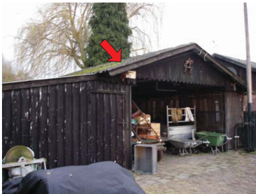
Foto 3; Schuur; asbestcement golfplaten dak. (M3)
