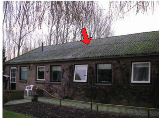
Foto 2; Woonhuis; asbestcement golfplaten dak. (M2)
