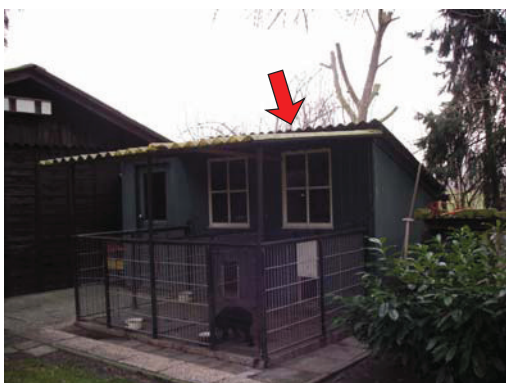
Foto 5; Hondenhok; asbestcement golfplaten dak. (M5)
