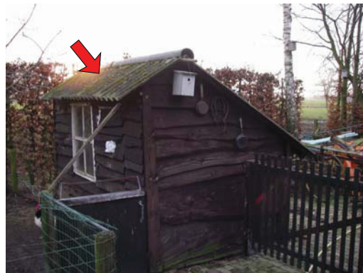
Foto 4; Kippenhok; asbestcement golfplaten dak. (M4)
