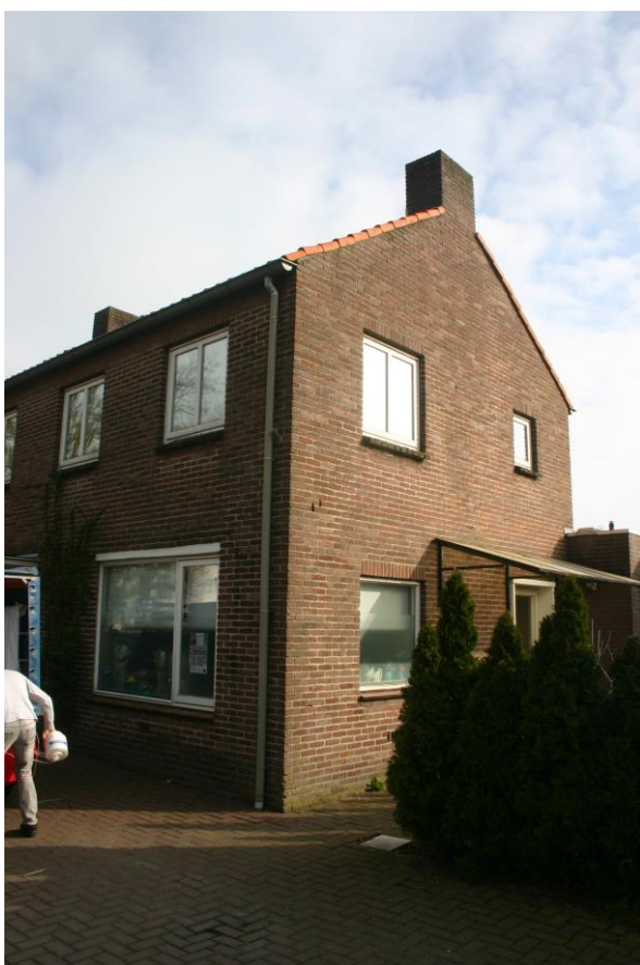
Figuur 3. De woning aan de Venraijseweg 1b.
