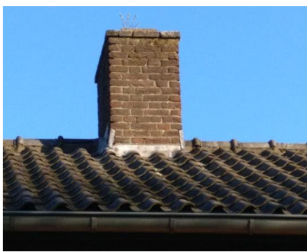
Foto 3: Schoorsteen van de woning
