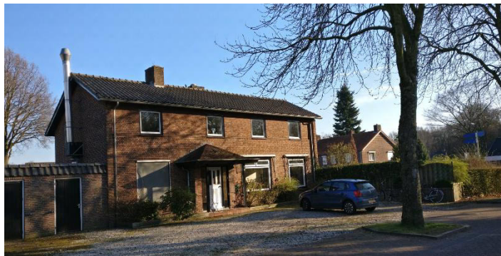
Foto 2: Foto gezicht op de woning aan de Museumlaan 33 te Overloon
