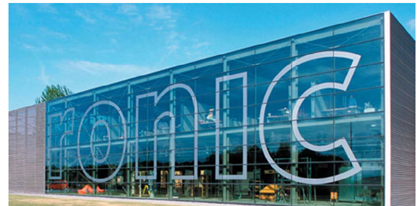
Bedrijfsnaam geïntegreerd in gevelbeeld
