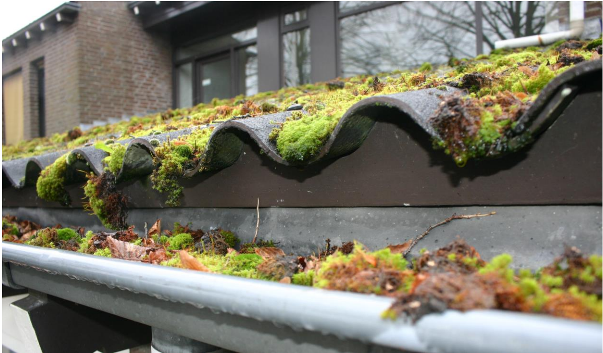
Figuur 4.4.1. De ruimte onder de onderste rij golfplaten is afdicht met nauw aansluitend vogelschroot.
