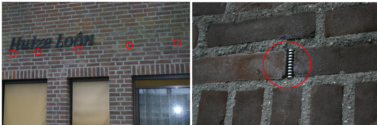
Figuur 4.4.3. De open stootvoegen (rood omcirkeld) aan de west- (l.) en zuidzijde (r.) zijn afgedicht met (nieuwe) stootvoegroosters.
