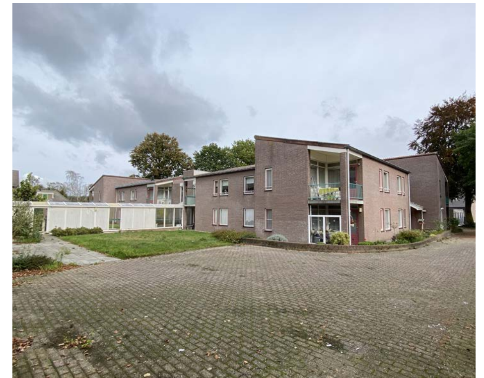
Bestaande situatie: Zicht op het bestaande appartementencomplex met alzijdige oriëntatie
