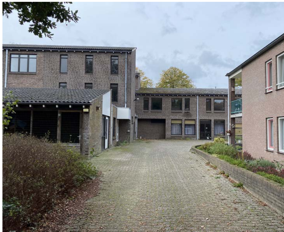
Bestaande situatie: Huize Loôn ter zijde van de Derpshei, alzijdige oriëntatie, 2/3 bouwlagen + kap
