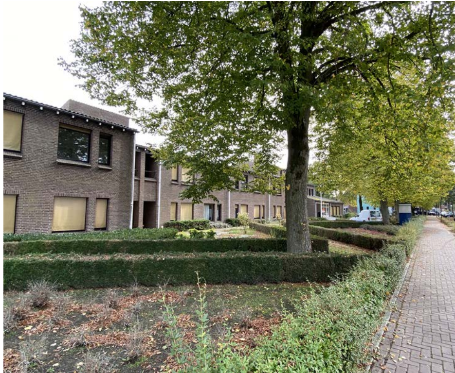
Bestaande situatie: Vergroend hof parallel aan de Engelseweg, bebouwing 2 lagen hoog met kap
