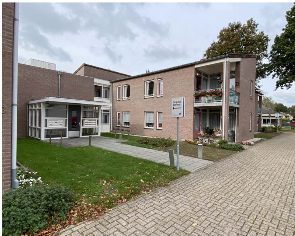
Bestaande situatie: Entree bestaand appartementencomplex vanaf de Derpshei
