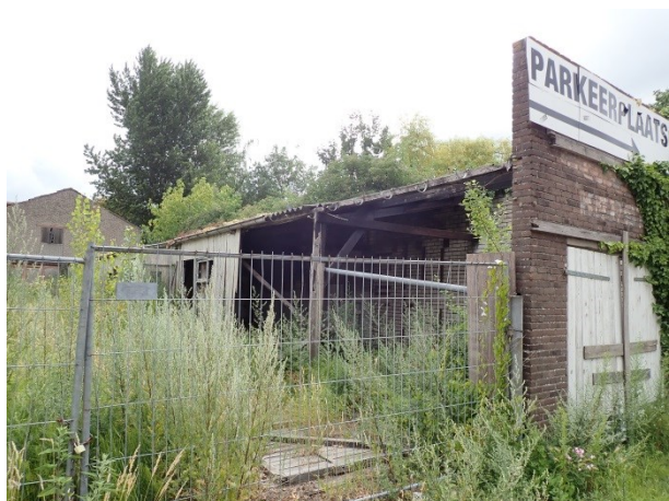
Foto 1: links, de te slopen schuur met en cementgebonden golfplaten dak en enkelwandige houten wand
