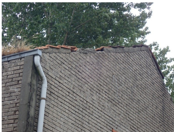
Foto 3: links, de te loods met verloren rij pannen en invliegopening naar spouwmuur
