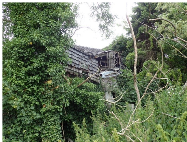
Foto 3: links, de te loods met verloren rij pannen en invliegopening naar spouwmuur
