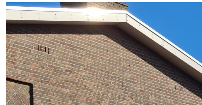
Figuur 189: Ventilatieopeningen in de westgevel van het complex aan de Marijkestraat
