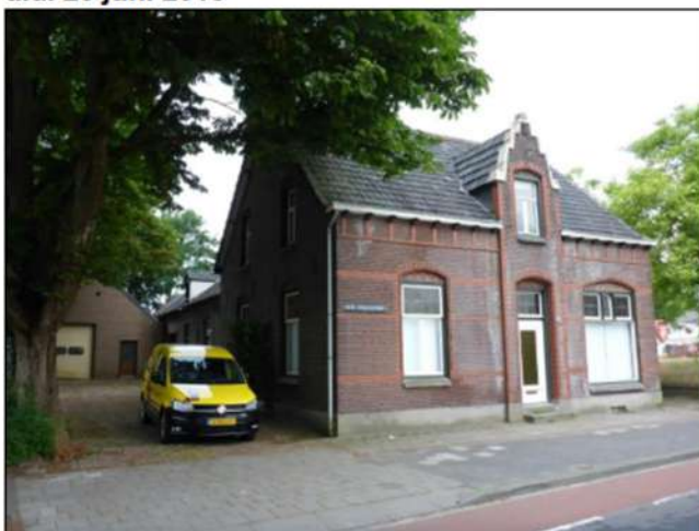
Foto 1: Woning en loodsen, Burgemeester Verkuijlstraat 60 te Boxmeer
