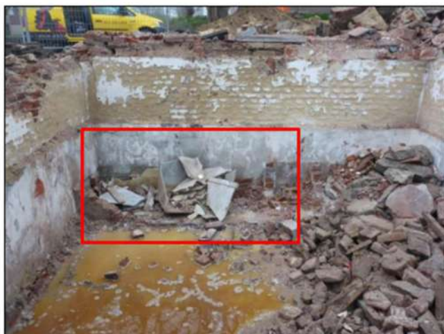
Foto 102: Kelder: Vormstuk (restanten bak) (M14AA)
