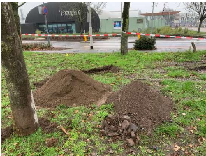
Foto 17: Overzicht sleuf PS06
