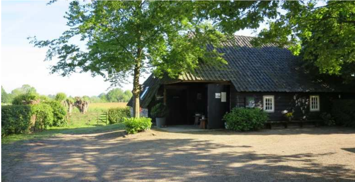
Bestaande "Vlaamse schuur".
