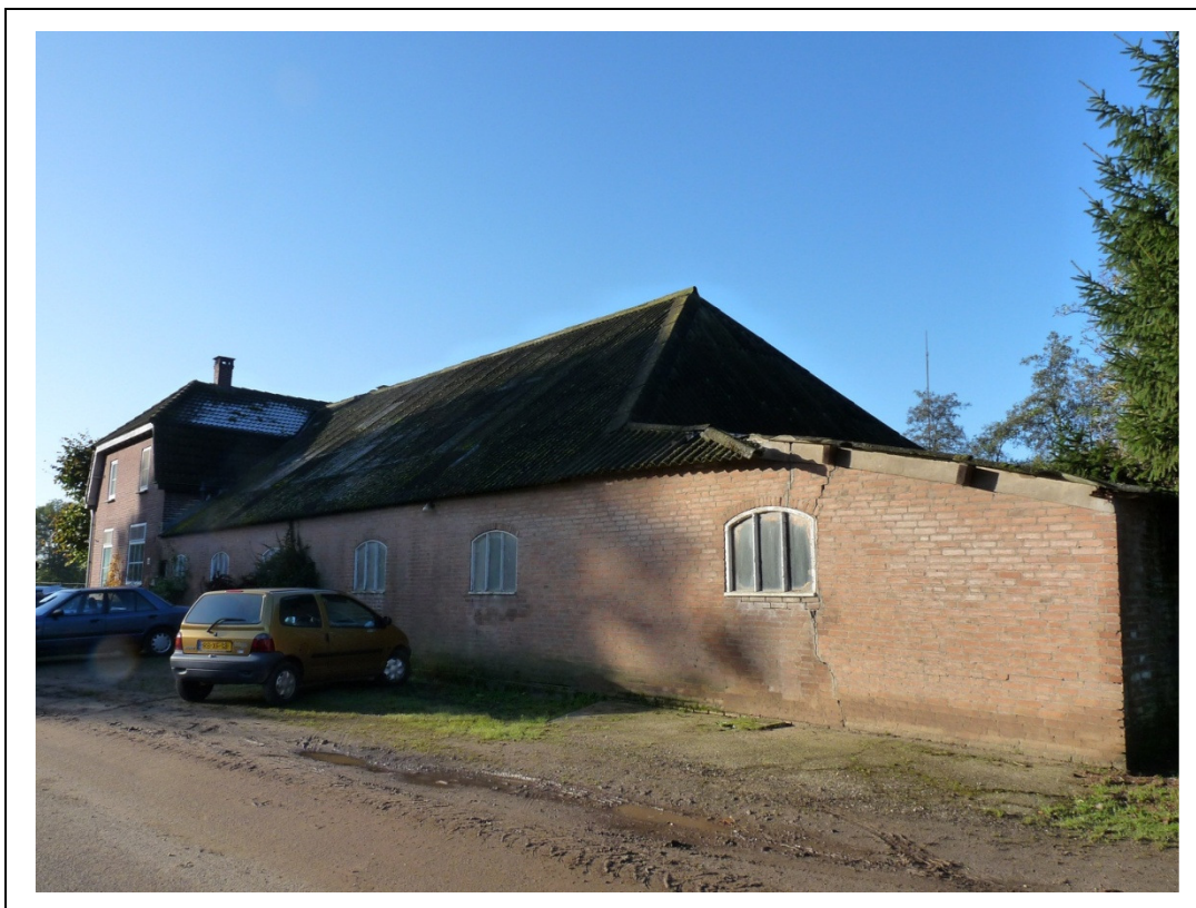
Foto 2. te slopen schuur op de bedrijfslocatie (verblijfplaats grootoorvleermuis)
