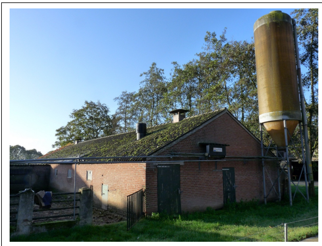
Foto 4. te slopen varkensschuur (leegstaand) op de bedrijfslocatie
