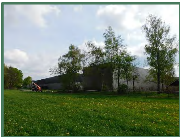
Overzicht zuidelijk gelegen bedrijfsgebouwen
