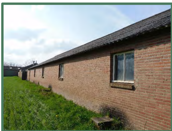
Gesloten muren met ingemetselde betonnen kozijnen
