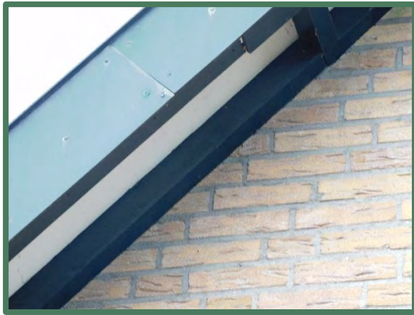
Aansluitende overstekbetimmering van woning
