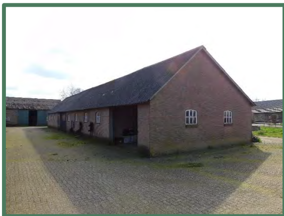
Stal 3 vanaf noord met deel erfverharding
