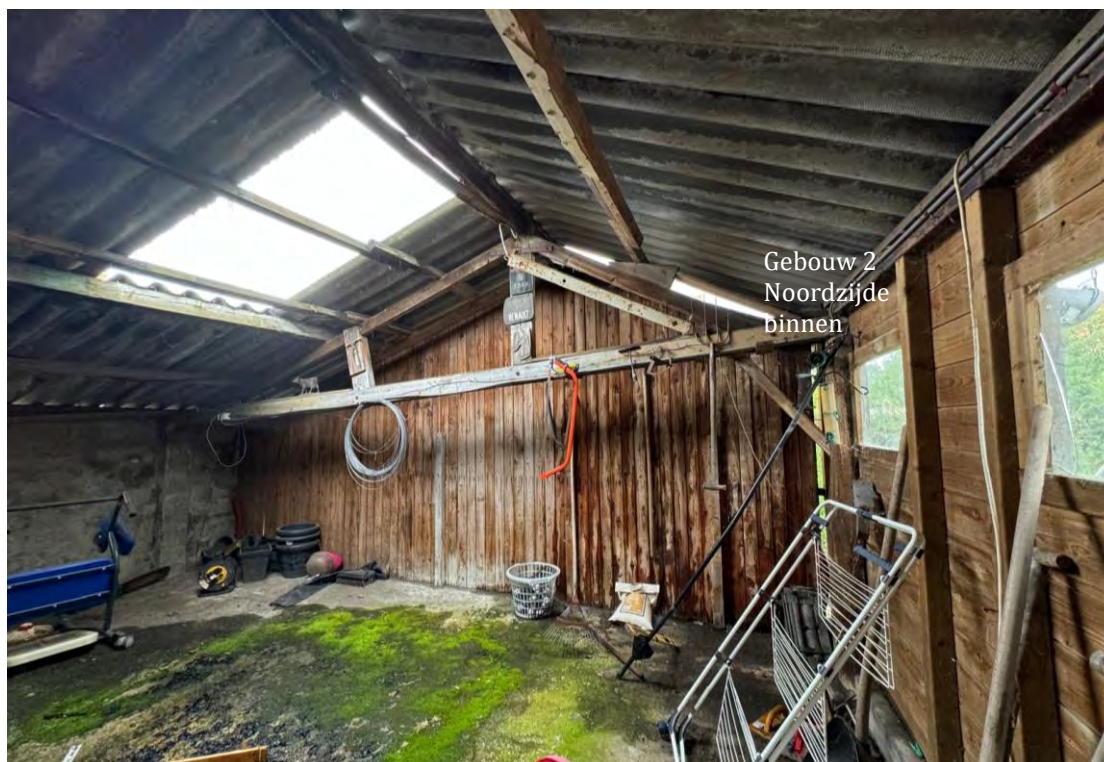
Figuur 5d: Zicht op de binnenzijde van gebouw 2. Géén sporen van of nestgelegenheid voor uilen of huismus aanwezig.
