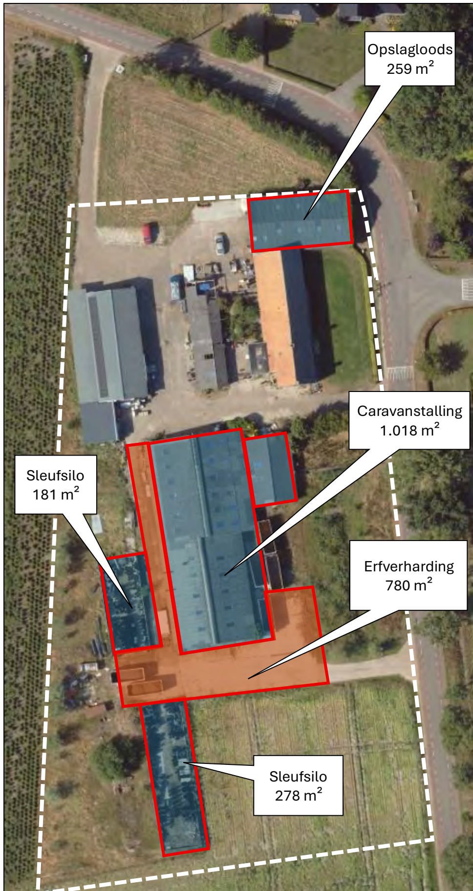
Afbeelding 1 Oppervlakte te slopen/saneren bedrijfsbebouwing, erfverharding en sleufsilos Peelsehuis 10
