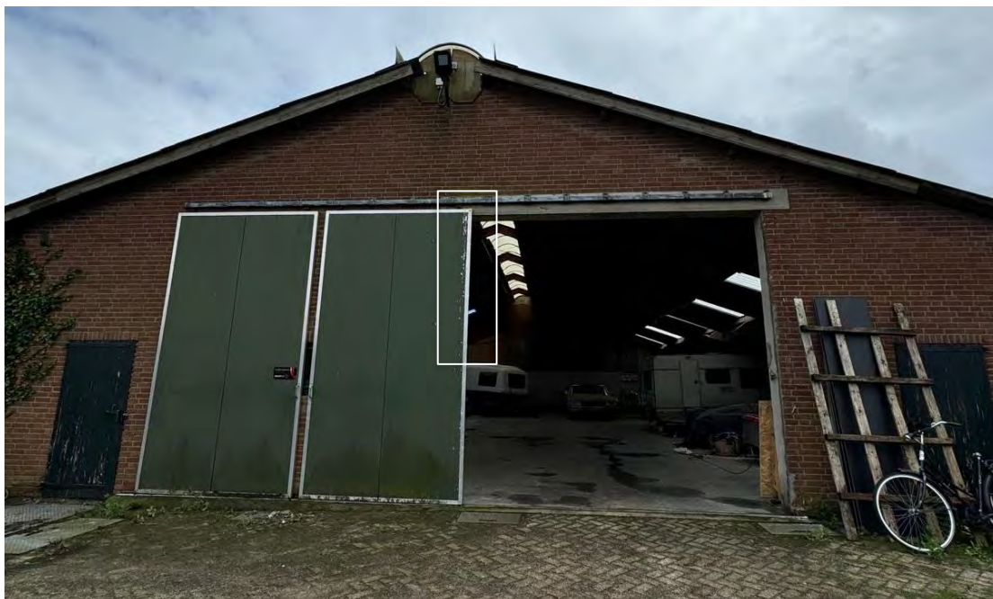
Figuur 5l: Zicht op de noordzijde van gebouw 6. Op de schuifdeur is mest van uil aanwezig.
