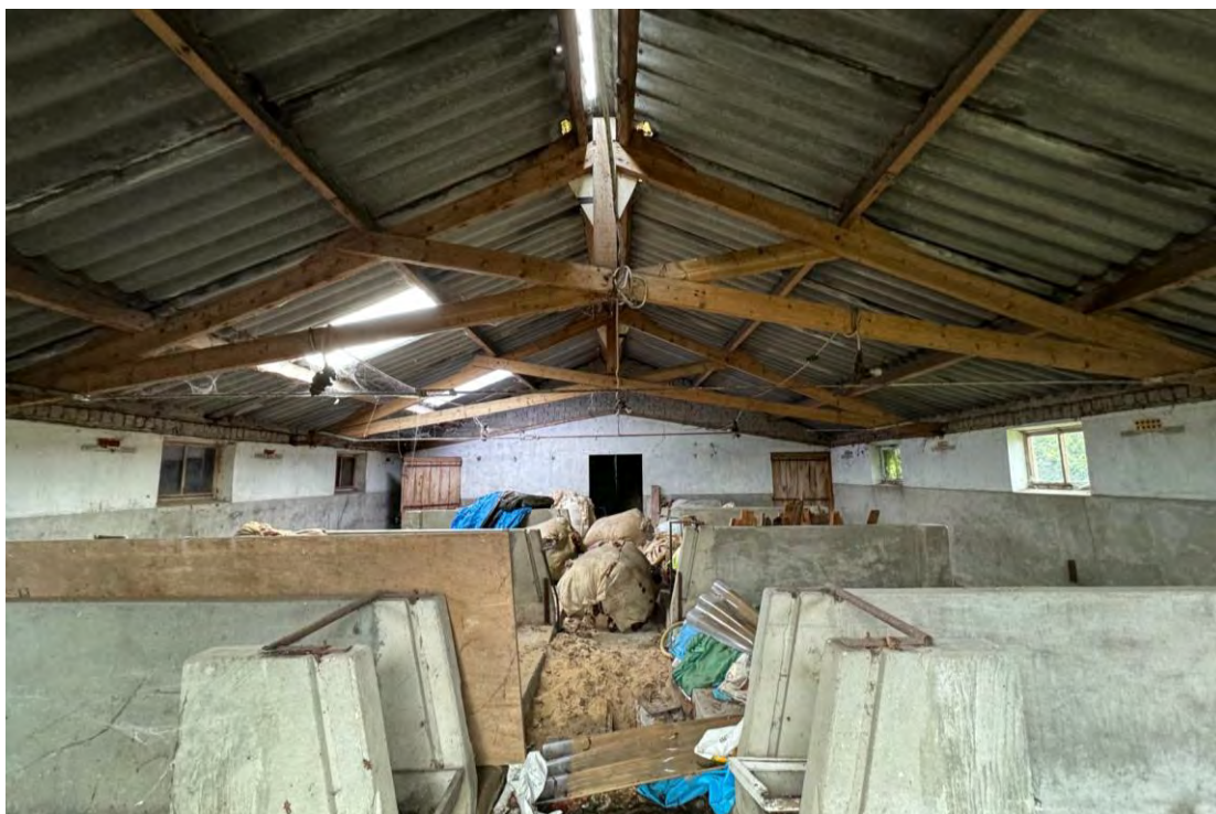
Figuur 5u: Zicht op binnenzijde gebouw 7. Hier zijn géén sporen van uilen of andere soorten zichtbaar.
