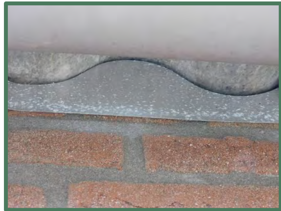
Muurplaat tussen golfplaten en wand
