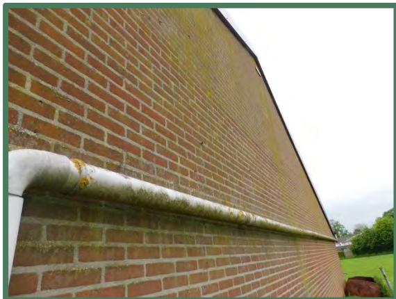
Kopgevel te slopen deel van de loods
