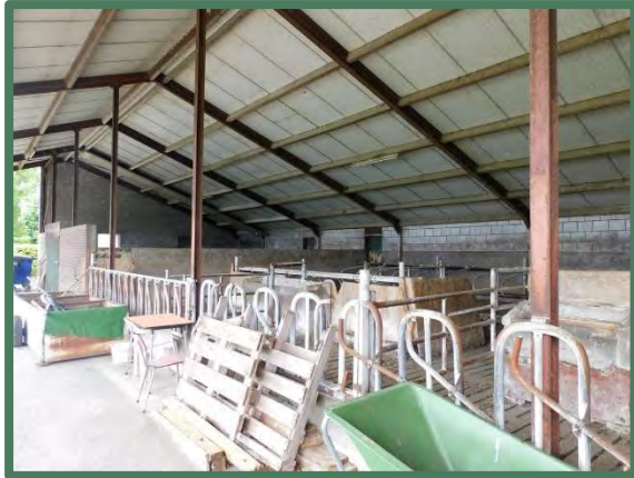
Te behouden deel van de loods vanuit noord
