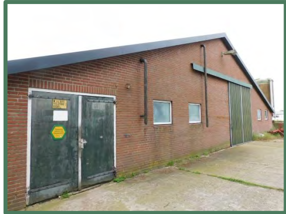
Te slopen rundveestal vanuit zuid
