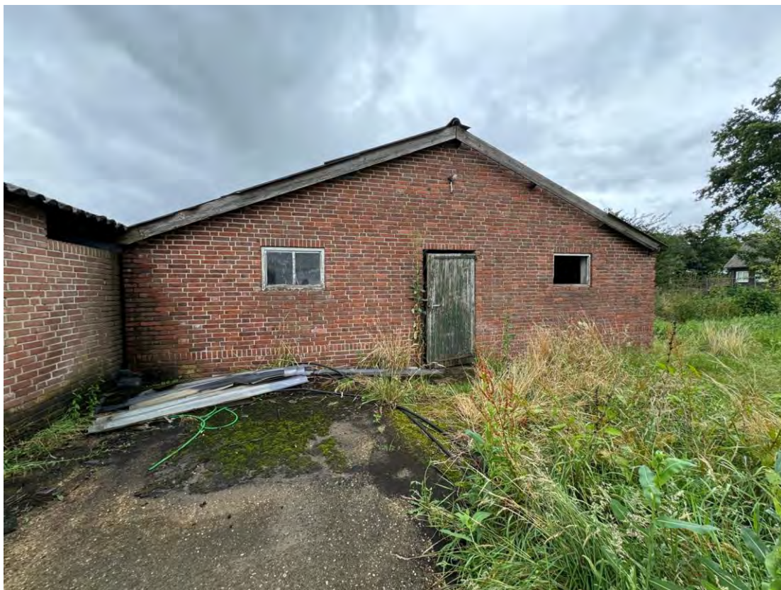
Figuur 5t: Buitenaanzicht gebouw 7.
