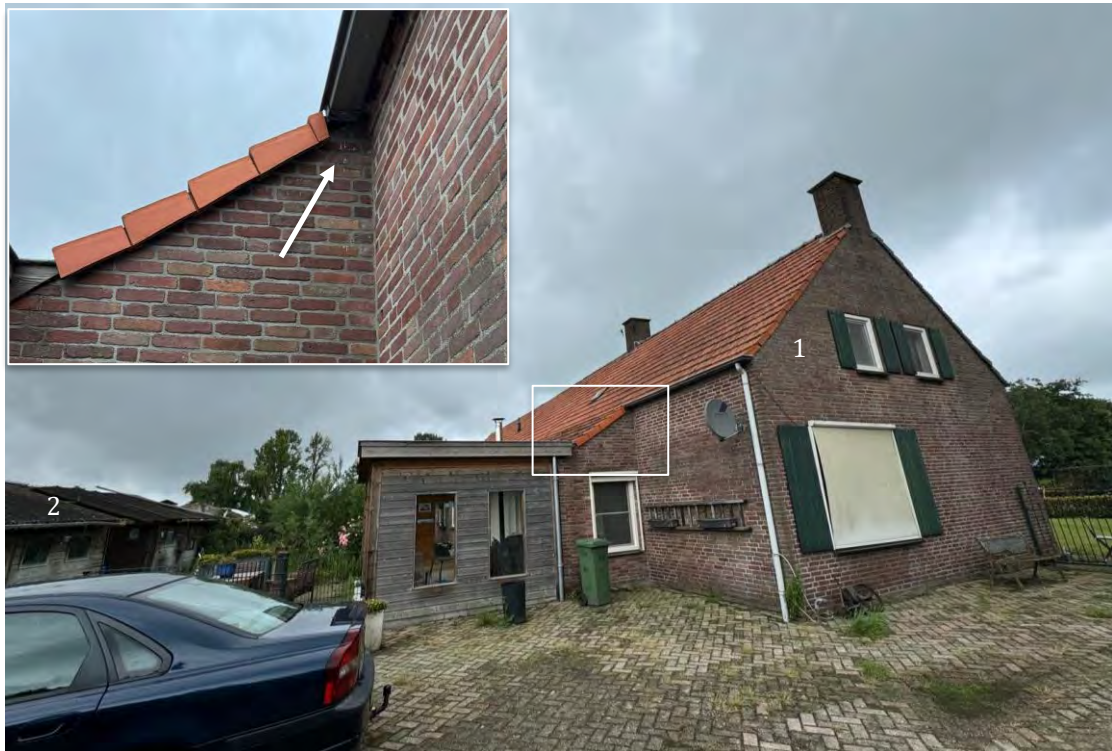
Figuur 5a: Zicht op de bedrijfswoning met pannendak en schoorstenen. Mogelijkheden voor nestelen door bijvoorbeeld huismus zijn aanwezig (zie inzet, pijl duidt op vogelmest).. Huismus is tevens daadwerkelijk aanwezig op het terrein.
