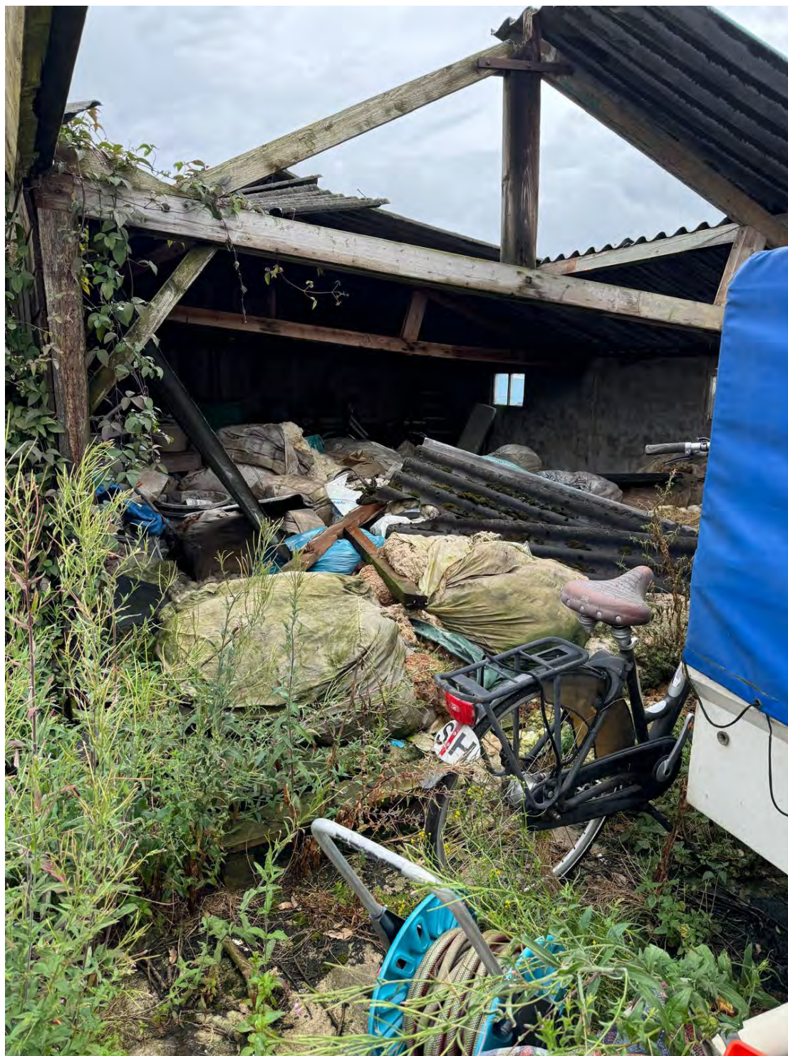
Figuur 5c: Zicht op de open binnenzijde van gebouw 2 bekeken vanuit het noorden. . Geén duidelijk zichtbare sporen van of nestgelegenheid voor uilen of huismus aanwezig.
