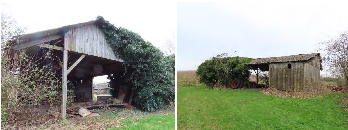
Afbeelding 3 t/m 8: Bestaande te slopen stal en veldschuren. Bron: BNL advies. Datum: 06-03-2024
