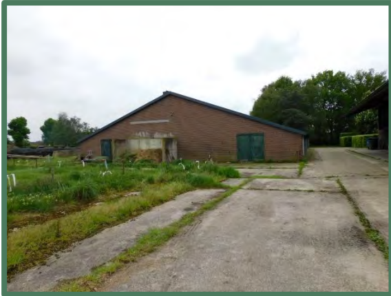
Overzicht te slopen rundveestal vanuit noord
