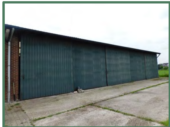
Overzicht te slopen deel van de loods vanuit oost
