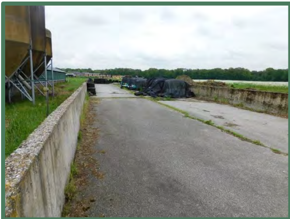
Overzicht te slopen sleufsilo
