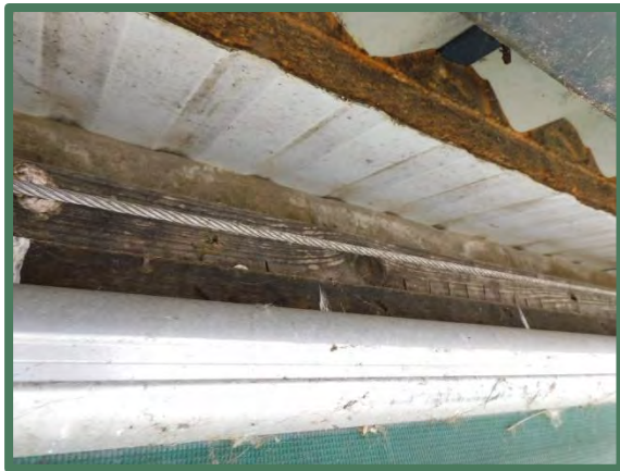
Muurplaat bij sandwichpanelen
