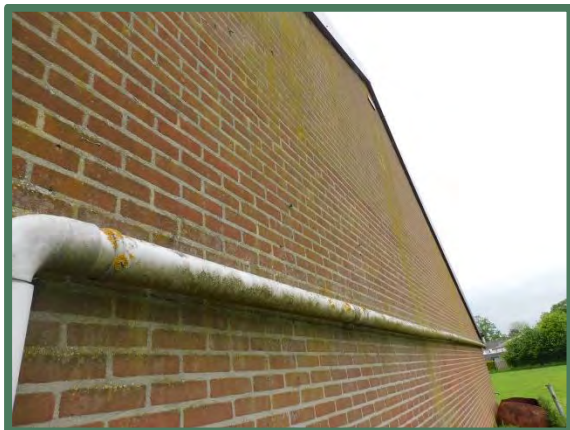
Kopgevel te slopen deel van de loods
