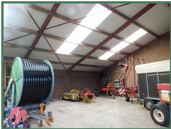
Binnenzijde te slopen loods
