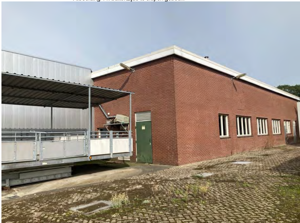
• Afbeelding 11: buitenzijde te slopen gebouw
