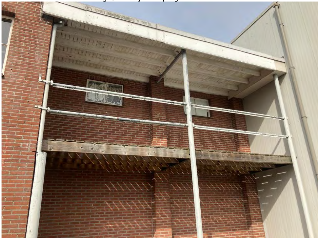
• Afbeelding 19: buitenzijde te slopen gebouw
