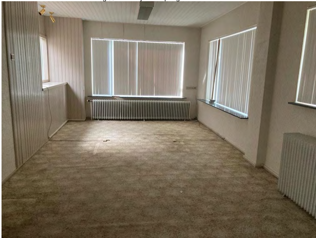
• Afbeelding 30: binnenzijde te slopen gebouw
