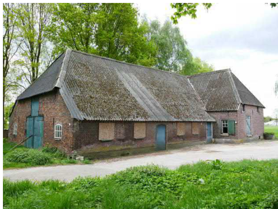
Figuur 52. De stal gezien vanuit het zuidoosten
