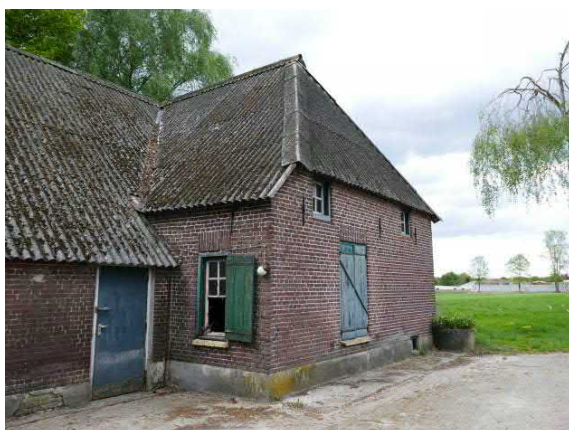
Figuur 45. Oostgevel woongedeelte met aansluitend stalgedeelte
