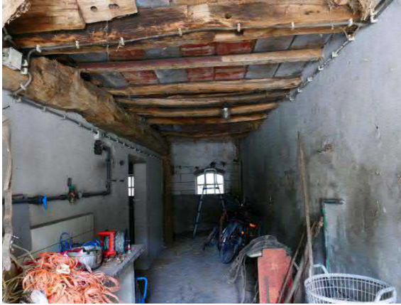
Figuur 78. Voorstal met aanrecht tegen later aangebrachte tussenmuur. Boven plafond van hergebruikte brede planken.
