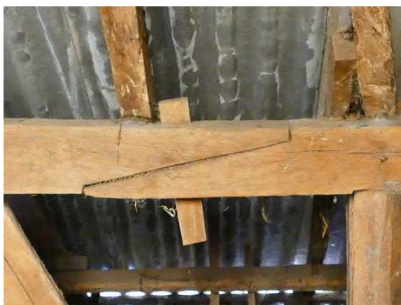
Figuur 76. Een las met wig in de gebintplaat
