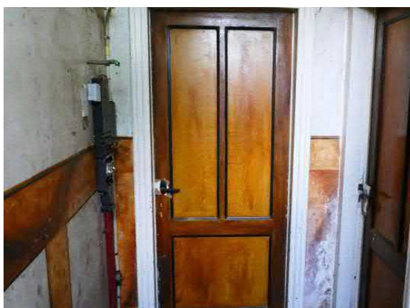
Figuur 31. De gang heeft twee paneeldeuren met houtnerfimitatie en een lambrisering met marmerimitatie conform de mode van 1925
