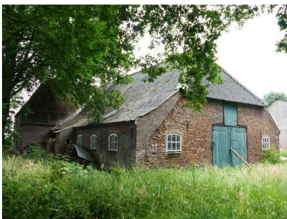
Figuur 36. Vanaf het midden van de vorige eeuw krijgt de stal een aantal betonnen ramen.
