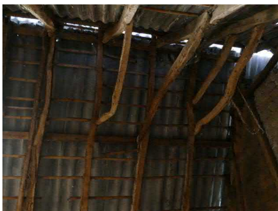
Figuur 15. De stal met het eiken gebint en sporenkap van het hallenhuis
