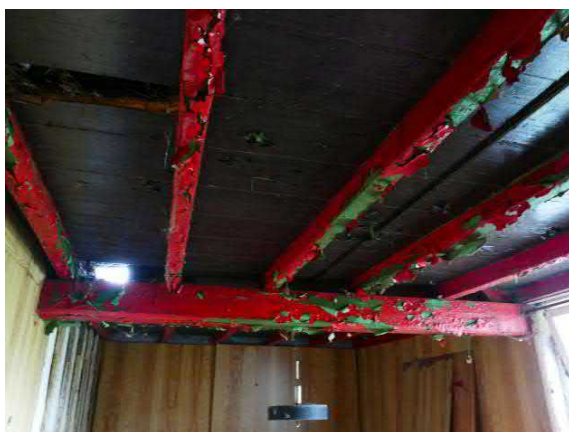
Figuur 24. Balkenplafond van "goeie kamer" in Krukaanbouw.
