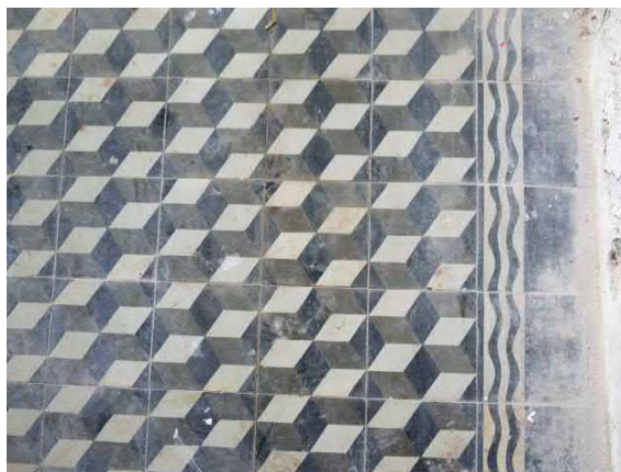
Figuur 71. In slaapkamer liggen estrikken met geometrisch motief.
