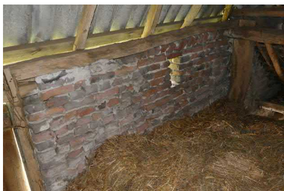
Figuur 86. Het uilengat in de eindgevel
