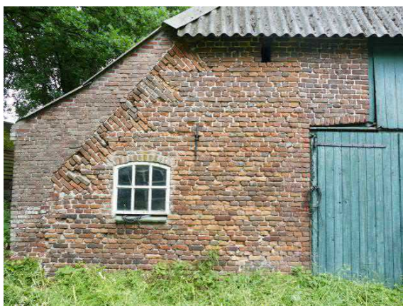
Figuur 13 Bij de eindgevel is aan de vlechtingen te zien dat de zijgevel van het hallenhuis erg laag is
