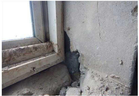
Kunststof kozijnen met DPC spouwstroken
