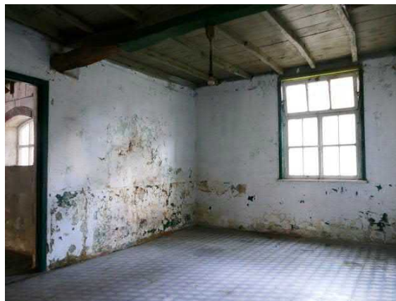
Figuur 73. De slaapkamer met links de later aangebrachte deur naar stal
