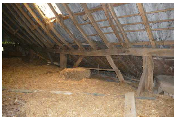
Figuur 87. Bovenzijde van de gebinten met rechts een voetschoor.
