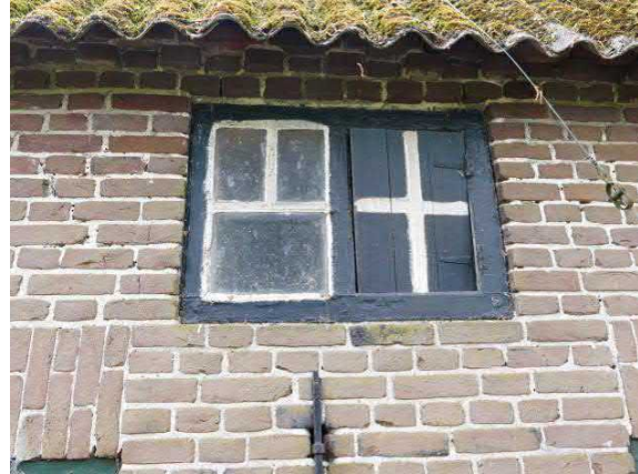
Figuur 18. Het bolkozijn zal nog van het hallenhuis zijn
