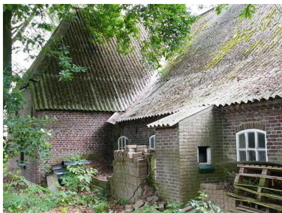
Figuur 54. Westgevel met uitbouw van het privaat
