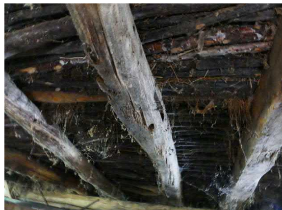
Figuur 83. Het slietenplafond van de stal
