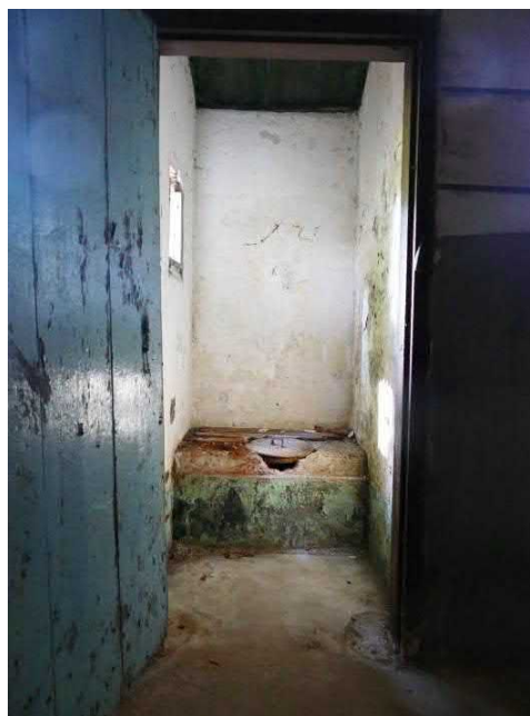
Figuur 85. Het privaat in de uitbouw van de westgevel
