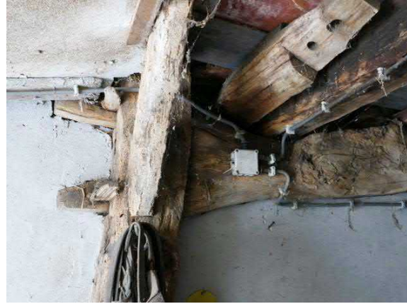
Figuur 79. Bij het vierde gebint is de gaffelvorm van de boomstam gebruikt als pen.
