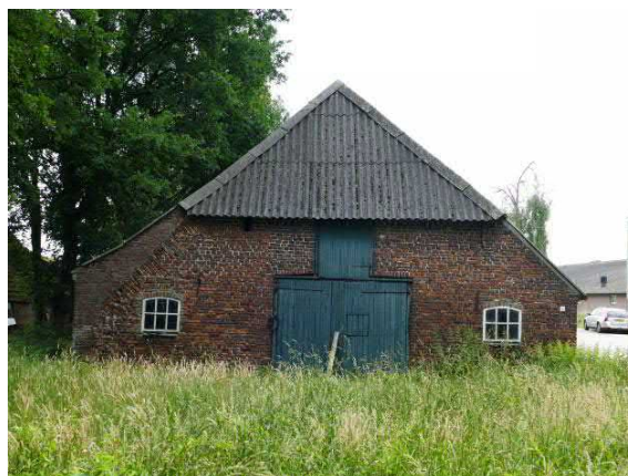
Figuur 55. Zuidgevel met dubbele mestdeur en hooiluik. De betonnen stalramen dateren uit de jaren vijftig.
