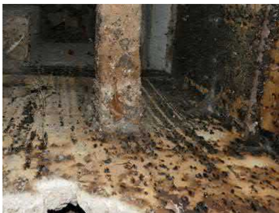
Figuur 30. Het schoorsteenkanaal van bovenaf gezien. Door het kanaal loopt een kachelpijp met links en rechts een kinderbalk, die van de moerbalk door de schoorsteen loopt.
