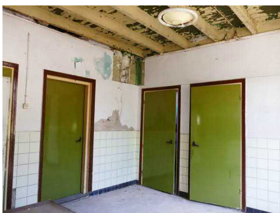
Figuur 62. Het balkenplafond in de keuken na verwijdering van het boardplafond.
