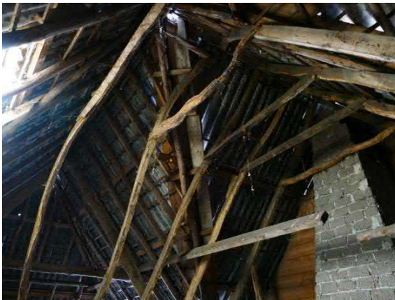
Figuur 19. De sporenkap van het hallenhuis loopt boven het woongedeelte tussen krukaanbouw en T-aanbouw gewoon door
