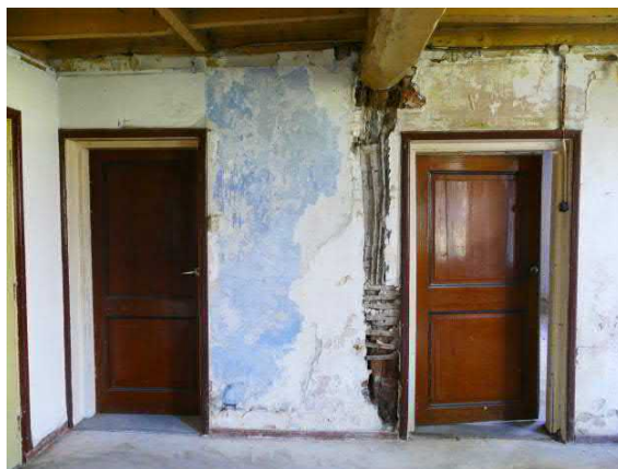
Figuur 69. Moerbalk met in de muur ingepakte stijl links naast paneel deur
