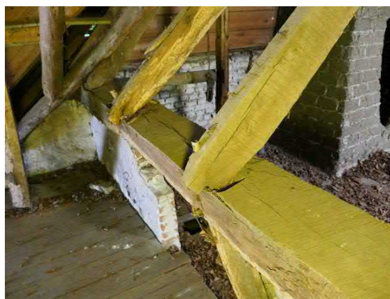
Figuur 77. Bevestiging kapsporen in gebintplaat met toognagels
