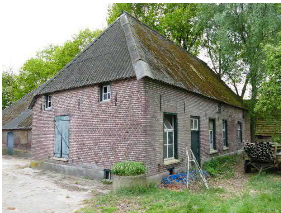
Figuur 28. De nieuwe kelder ligt in de noordoosthoek en heeft twee kelderramen. Het raam van de opkamer is even groot als de andere ramen en ligt op gelijk niveau. Dit is gedaan om meer gelijkvormigheid aan te brengen in de gevel. Dit geeft het gebouw meer status
