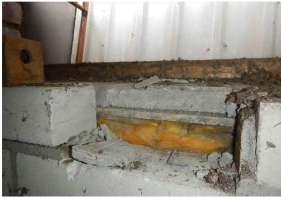
Spouwdichtlegging met hout
