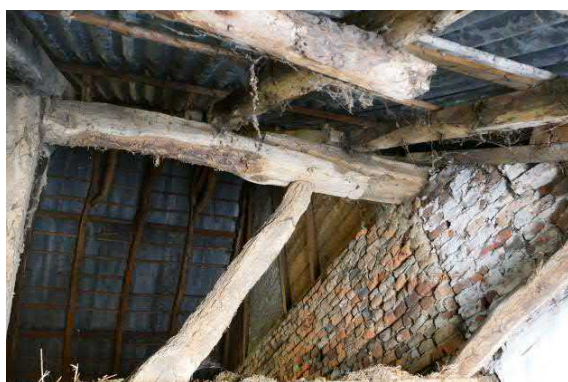
Figuur 88. Las in de gebintplaat achter de brandgevel
