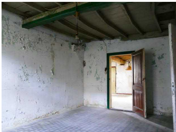
Figuur 72. Het gestripte balkenplafond in de slaapkamer
