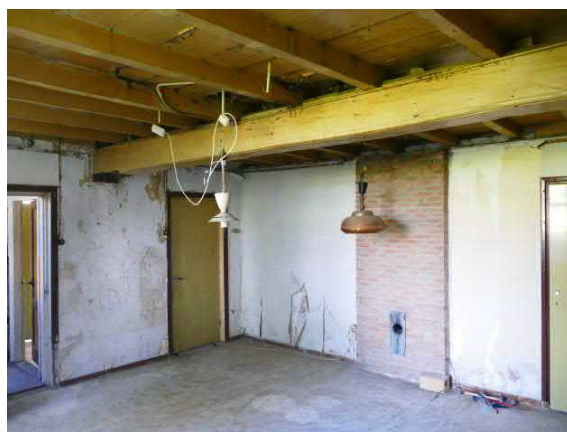
Figuur 14. De fraaiste balk is de moerbalk in de herd
