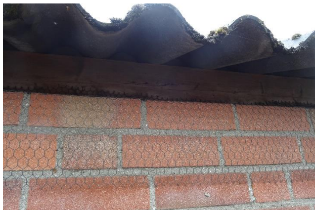
Afbeelding 7: Daken van de te slopen stallen zijn niet toegankelijk voor huismussen door de aanwezigheid van vogelschroot onder de golfplaten en vogelwerend gaas. Bron: R.J.L. Bijvelds 20-05-2021
