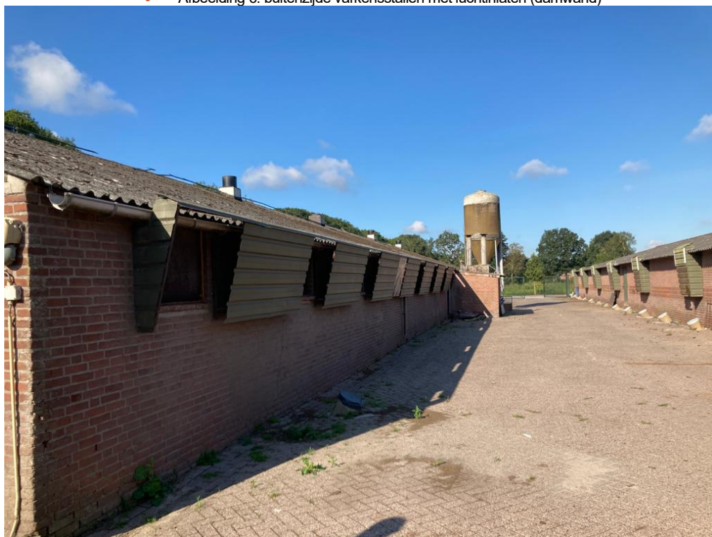
• Afbeelding 6: buitenzijde varkensstallen met luchtinlaten (damwand)
