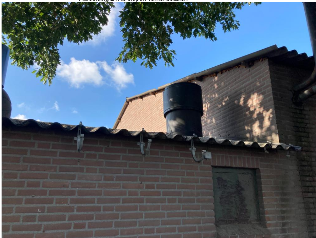
• Afbeelding 21: te slopen varkensstallen
