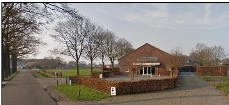
Figuur 4: Foto bestaande situatie
