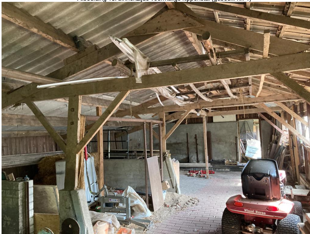
• Afbeelding 13: binnenzijde voormalige kippenstal (gebouw nr. 4)
