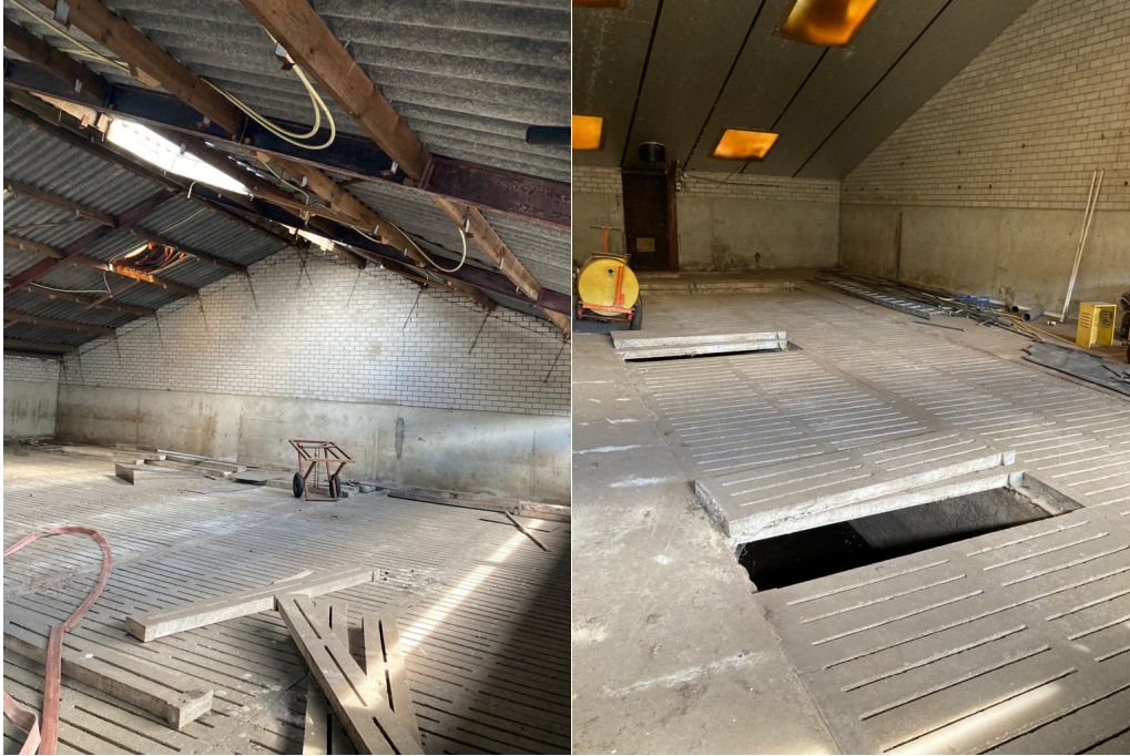
• Afbeelding 4 en 5: binnenzijde voormalige varkensstal (gebouw nr. 3)
