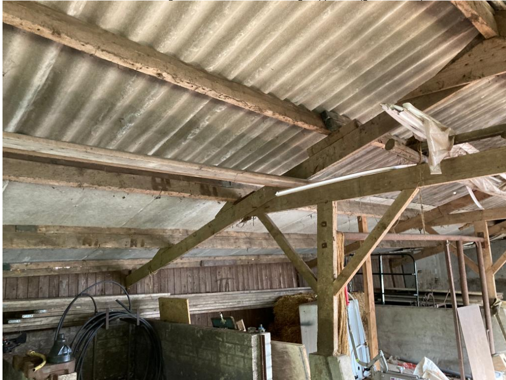
• Afbeelding 14: dakconstructie voormalige kippenstal (gebouw nr. 4)
