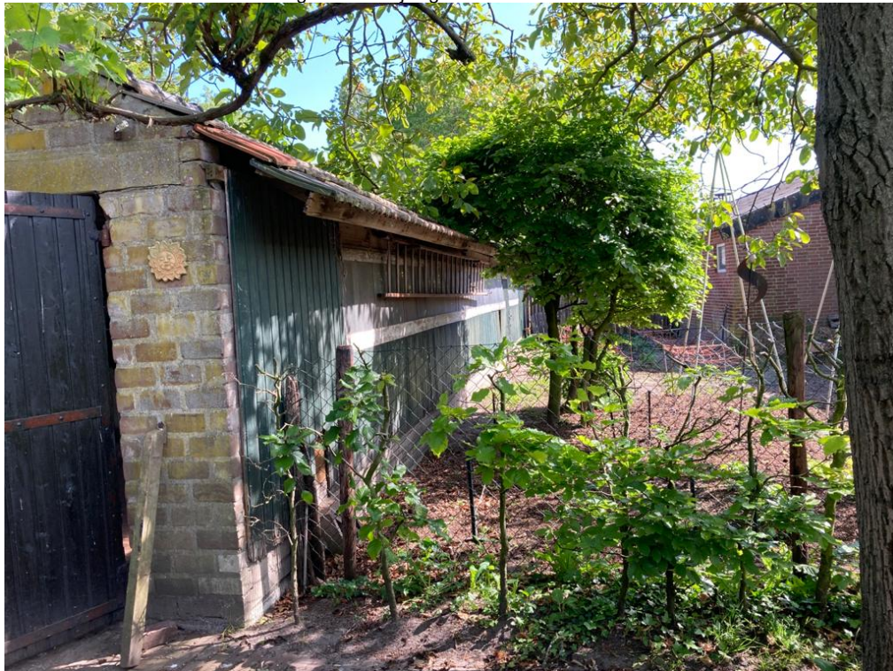
• Afbeelding 15: buitenzijde gebouw nr. 4
