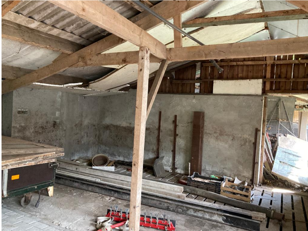
• Afbeelding 12: binnenzijde voormalige kippenstal (gebouw nr. 4)
