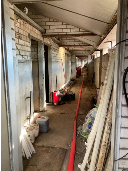
• Afbeelding 8: binnenzijde voormalige varkensstal (gebouw nr. 3)
