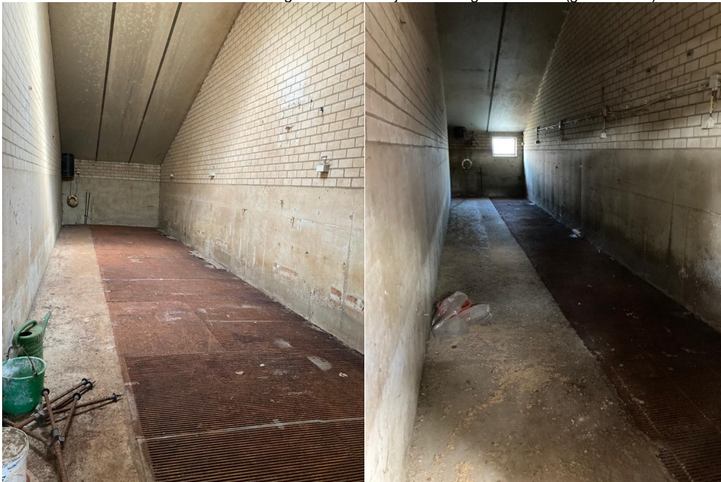
• Afbeelding 6 en 7: binnenzijde voormalige varkensstal (gebouw nr. 3)
