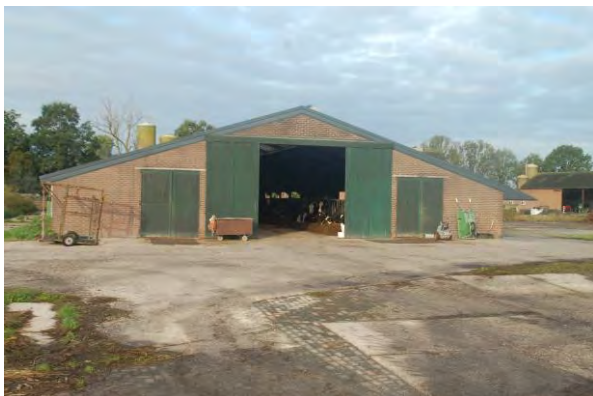
Afbeelding: achterzijde ligboxenstal
