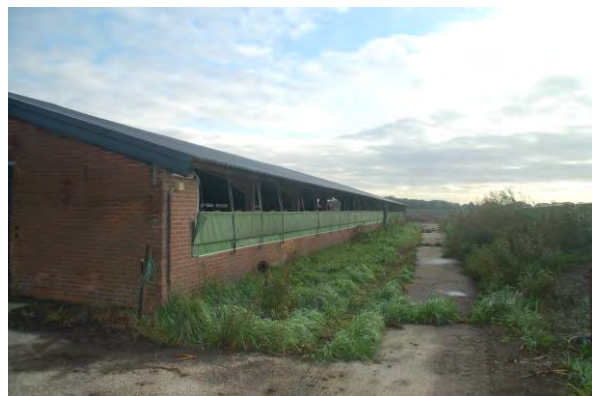
Afbeelding: rechterzijgevel ligboxenstal
