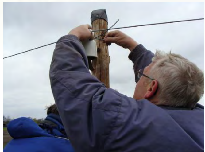
Bovenaanzicht paal met haak en isolator
