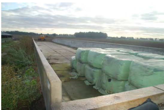
Afbeelding: sleufsilo naast de ligboxenstal
