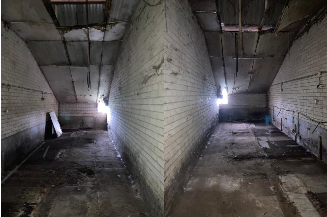
• Afbeelding 10 en 11: binnenzijde varkensstallen deels gestript
