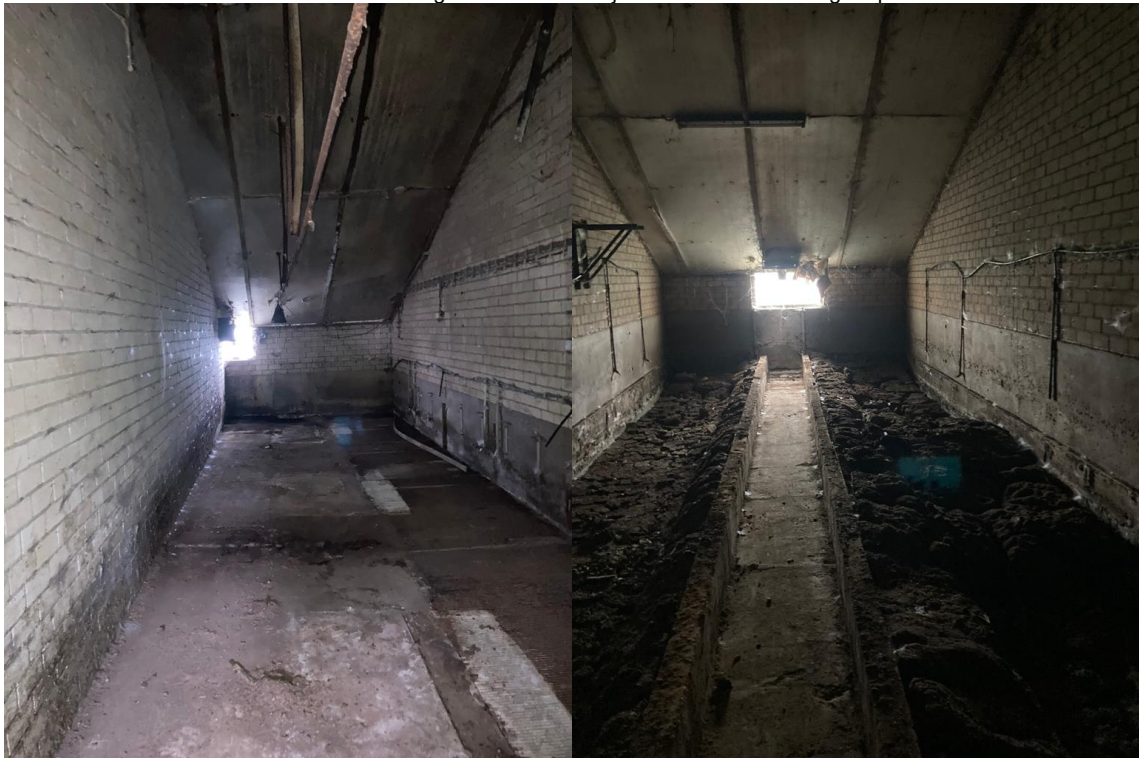
• Afbeelding 12 en 13: binnenzijde varkensstallen deels gestript
