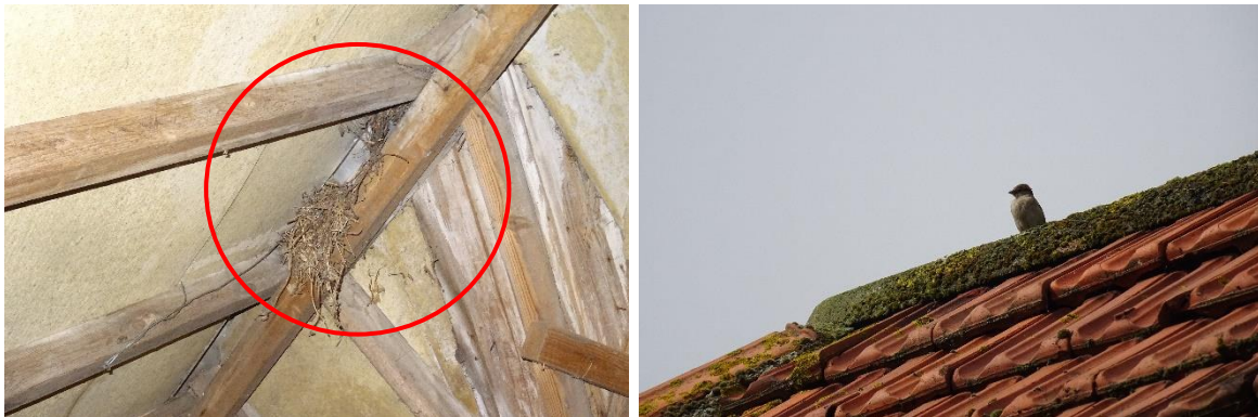
Afbeelding 11 en 12: Nestmateriaal huismus en een huismus op het dak van de te slopen voormalige bedrijfswoning. Bron: R.J.L. Bijvelds 20-05-2021
