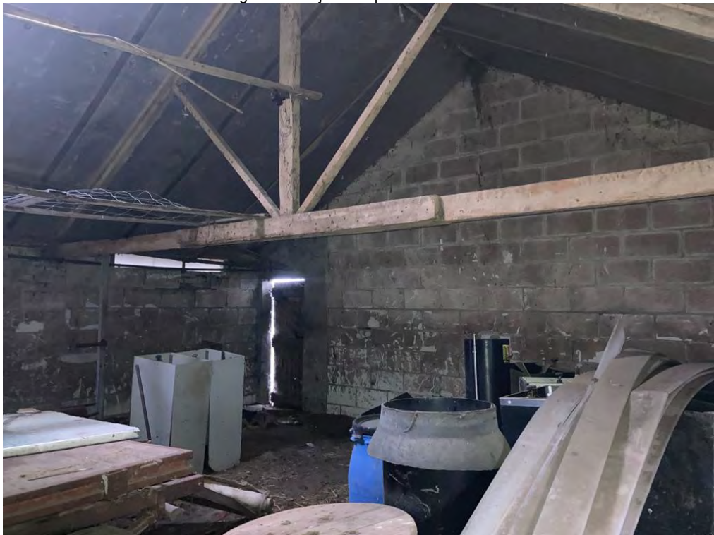
• Afbeelding 4: binnenzijde te slopen varkensstal
