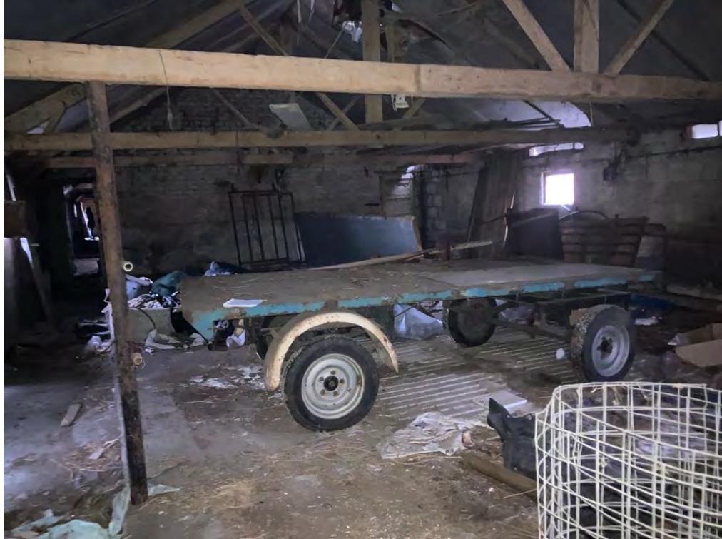
• Afbeelding 3: binnenzijde te slopen voorste varkensstal
