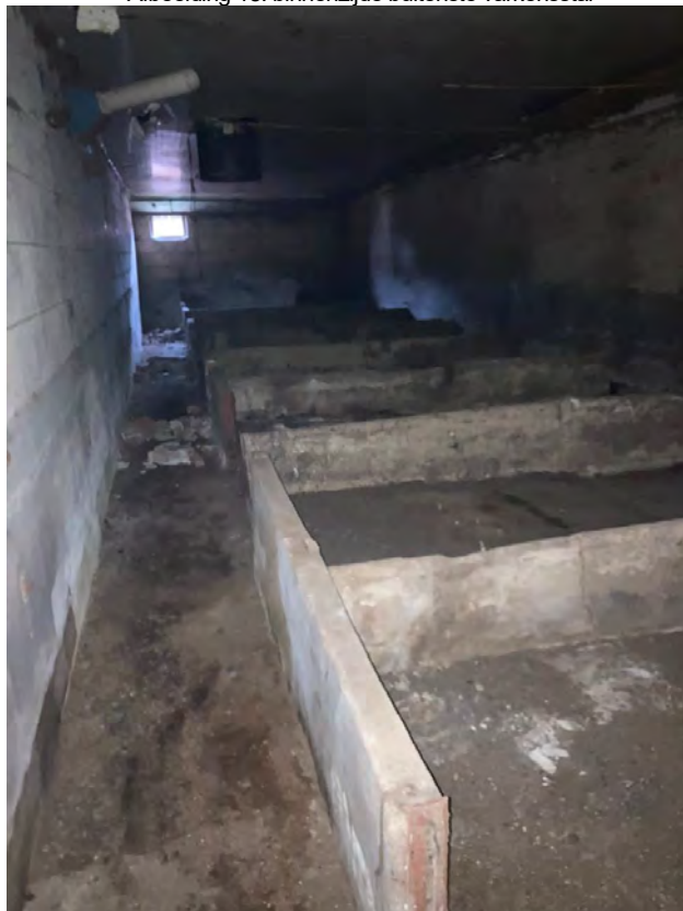
• Afbeelding 18: binnenzijde buitenste varkensstal
