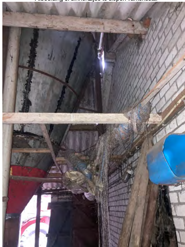
• Afbeelding 6: binnenzijde te slopen varkensstal
