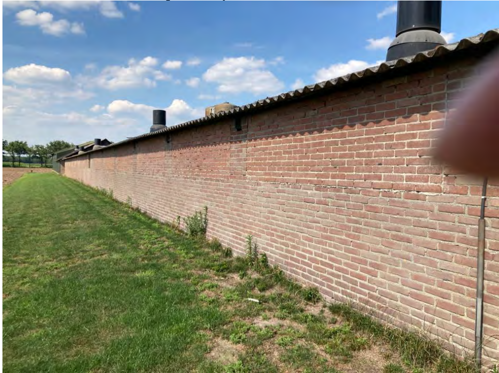
• Afbeelding 23: buitenzijde varkensstallen
