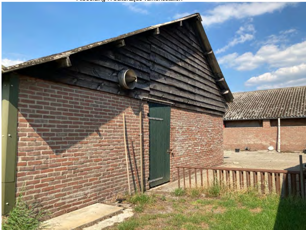
• Afbeelding 7: buitenzijde varkensstallen
