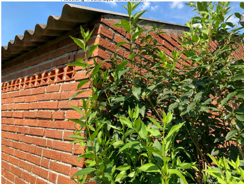
• Afbeelding 4: buitenzijde varkensstallen
