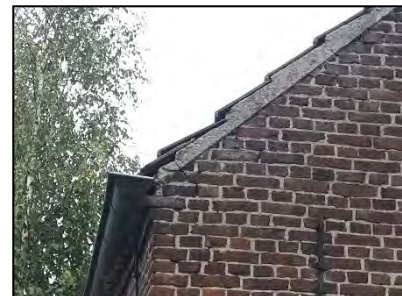
Figuur 13. Ruimte onder dakpannen te bereiken via de dakgoot.
