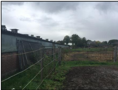
Figuur 9. Noordwest zijde van de achterste stal met een deel van het weiland.
