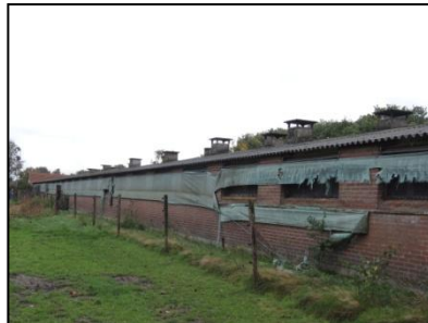
Figuur 10. Noordwest zijde van de achterste stal met een deel van het weiland.
