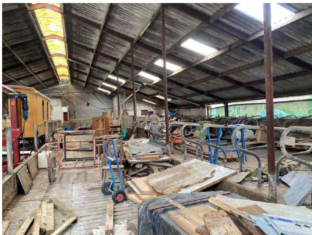
• Afbeelding 14: binnenzijde te slopen ligboxenstal
