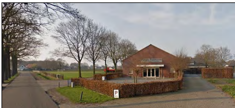
Figuur 4: Foto bestaande situatie
