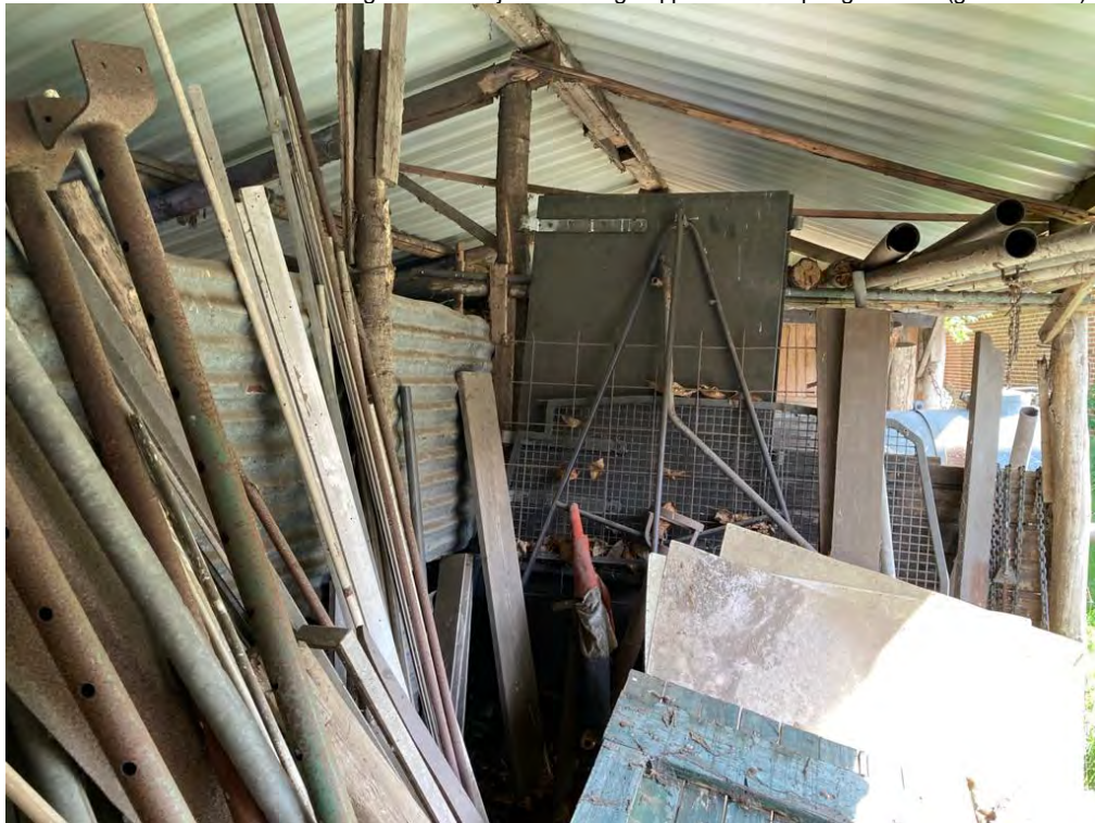
• Afbeelding 11: binnenzijde voormalige kippenstal met opslag diversen (gebouw nr. 4)
