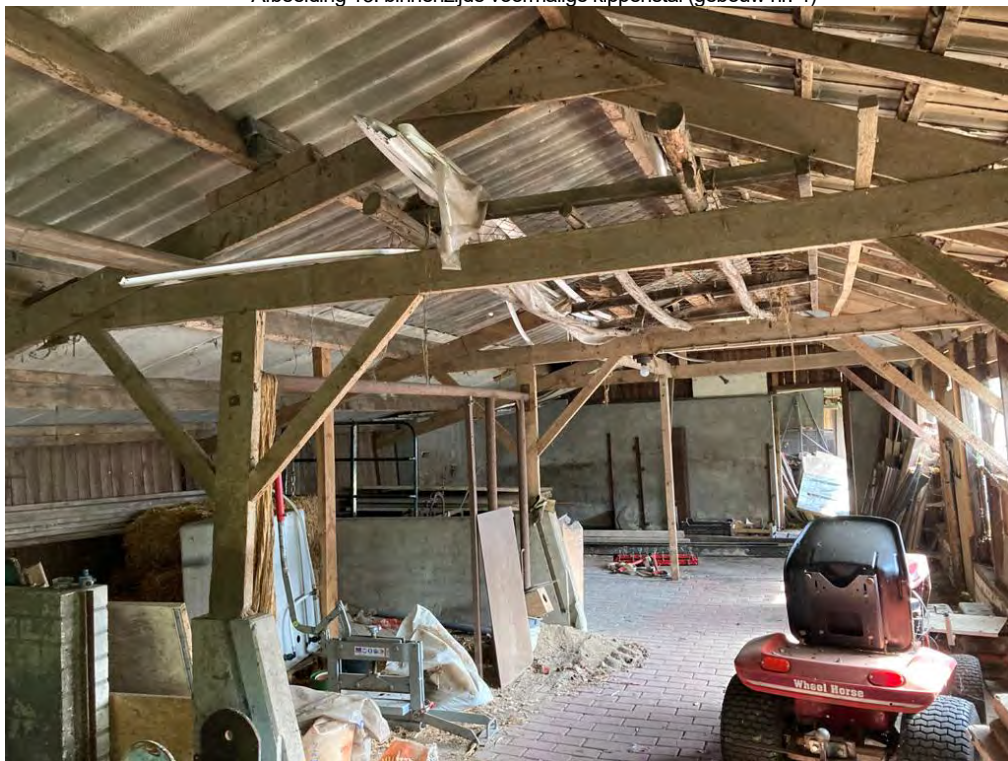
• Afbeelding 13: binnenzijde voormalige kippenstal (gebouw nr. 4)
