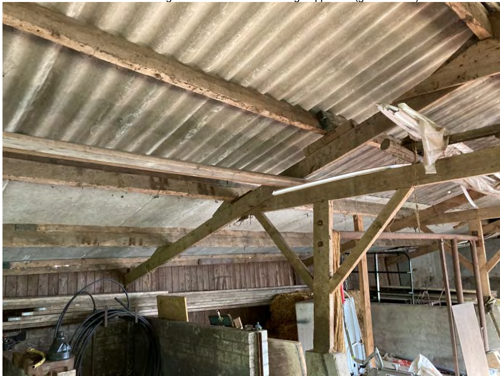
• Afbeelding 14: dakconstructie voormalige kippenstal (gebouw nr. 4)
