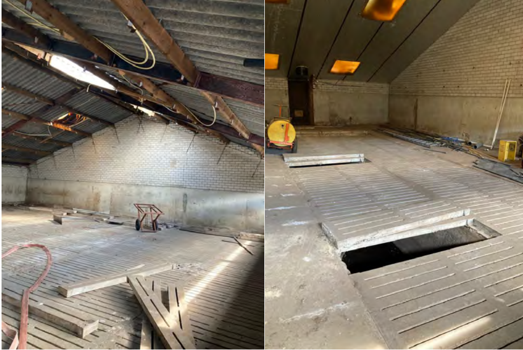
• Afbeelding 4 en 5: binnenzijde voormalige varkensstal (gebouw nr. 3)
