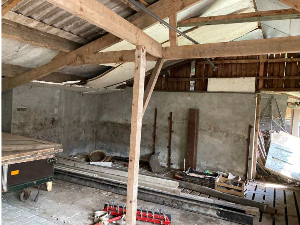
• Afbeelding 12: binnenzijde voormalige kippenstal (gebouw nr. 4)
