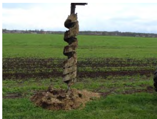
Boren met grondboor
