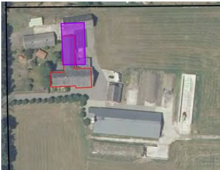
Figuur 2-4: beoogde locatie nieuwe loods.
