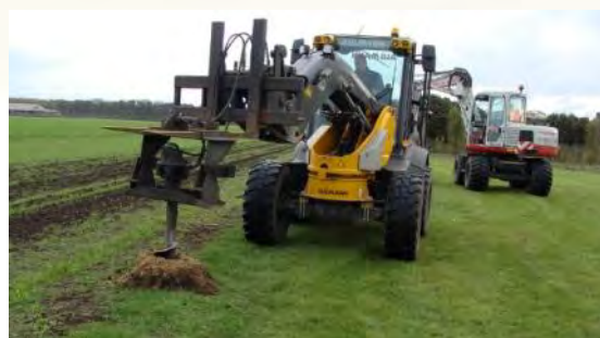
Het maken van een gat voor de paal
