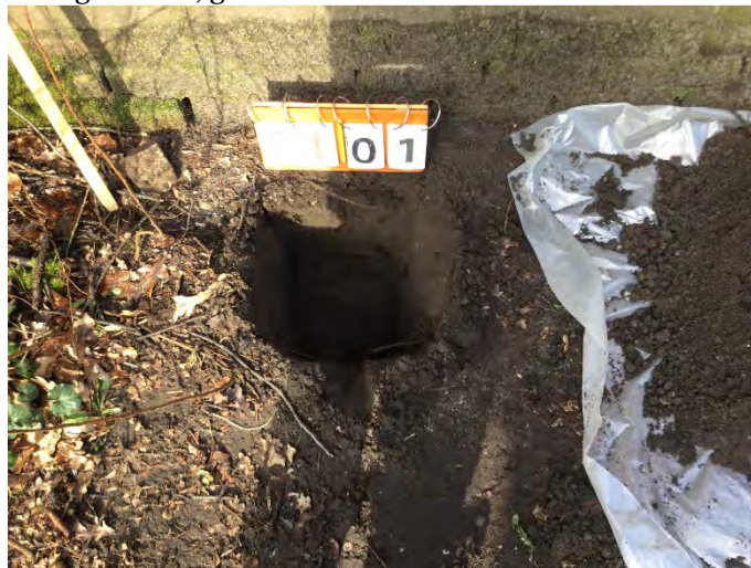
Foto gebouw 1, gat 102
