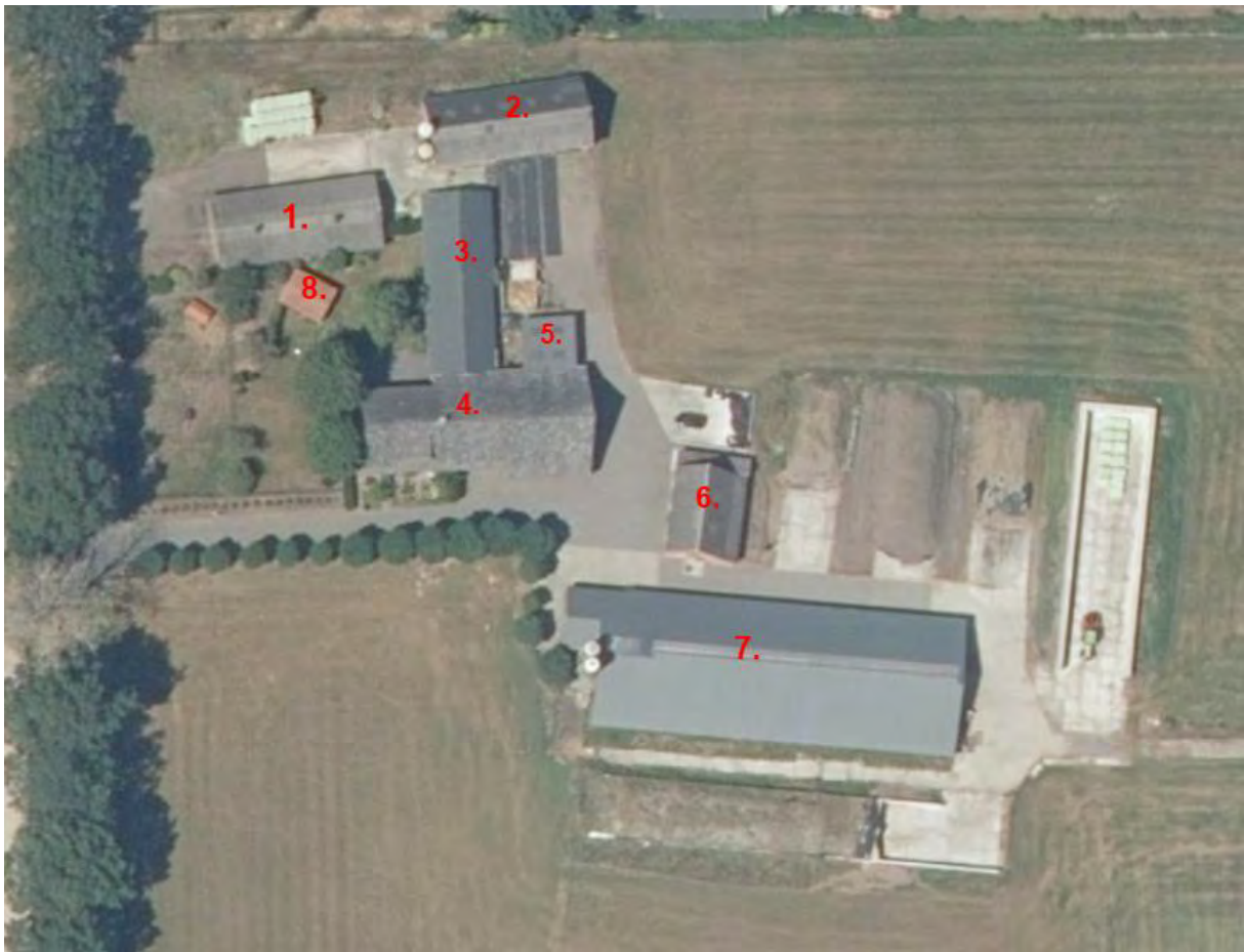
Figuur 2-1: overzicht plangebied en opstallen
