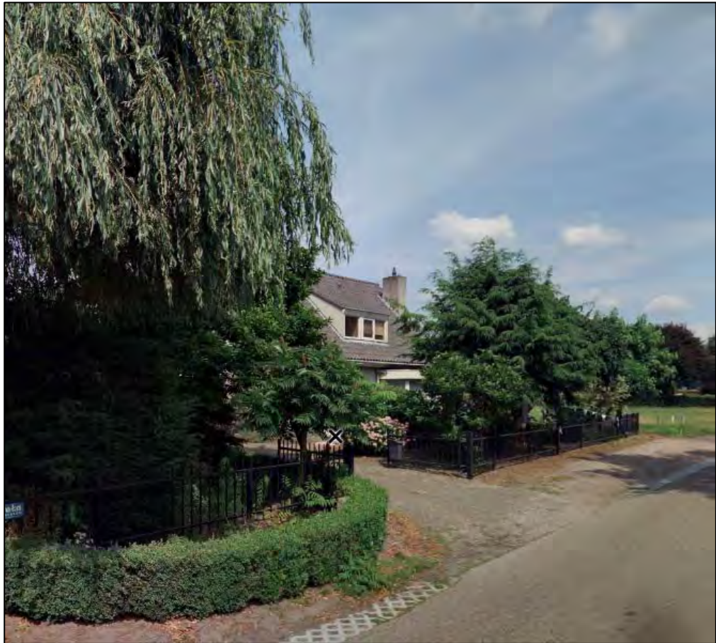
Figuur 4 Zijaanzicht (links) van de woning op de Peelstraat 5
