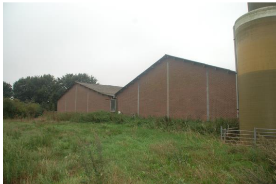
Afbeelding: achterzijde te slopen stallen.
