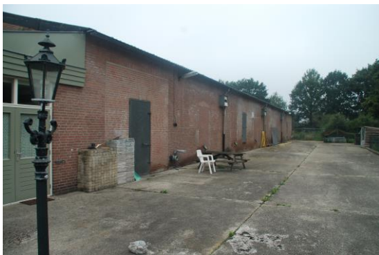
Afbeelding: zij aanzicht te slopen stallen.
