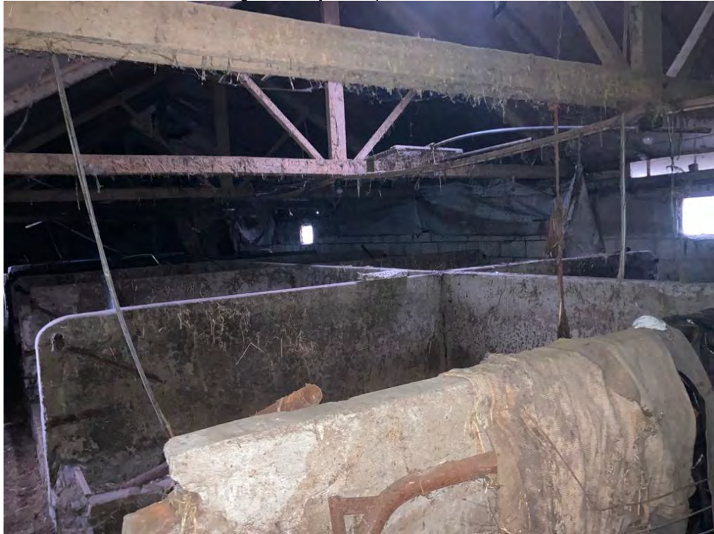
• Afbeelding 5: binnenzijde te slopen varkensstal
