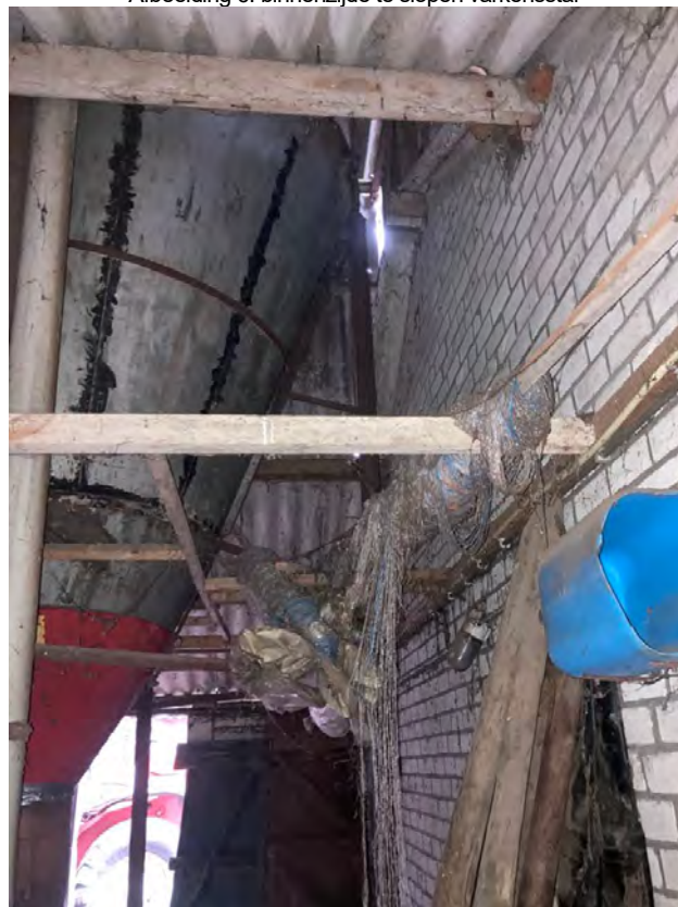
• Afbeelding 6: binnenzijde te slopen varkensstal
