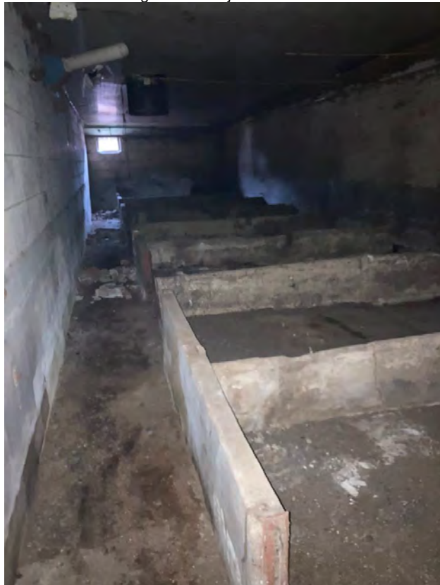
• Afbeelding 18: binnenzijde buitenste varkensstal
